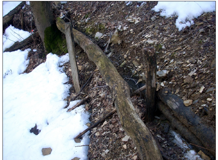
Fig. 5.3: particolare delle palizzate di fig. 5.2. Si nota il cattivo stato di manutenzione dell'opera.
