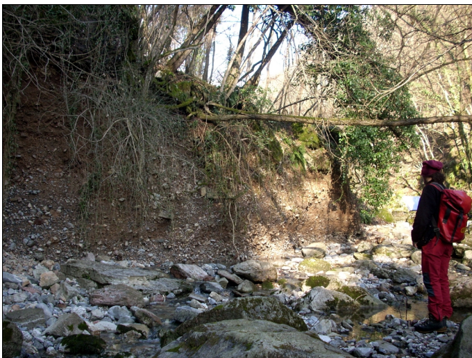
Fig. 8.1: erosione di sponda in destra idrografica a Nord della confluenza con la Val da Puzoo.
