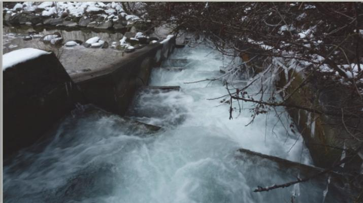
LA CENTRALE DI CAPRIOLO È DOTATA DI PASSAGGIO PER PESCI MA IL DISLIVELLO FRA I BACINI DEL PASSAGGIO È TROPPO ELEVATO PER PERMETTERE LA RISALITA DELLA FAUNA ITTICA. LA SCALA NON RISULTA QUINDI EFFICACE
