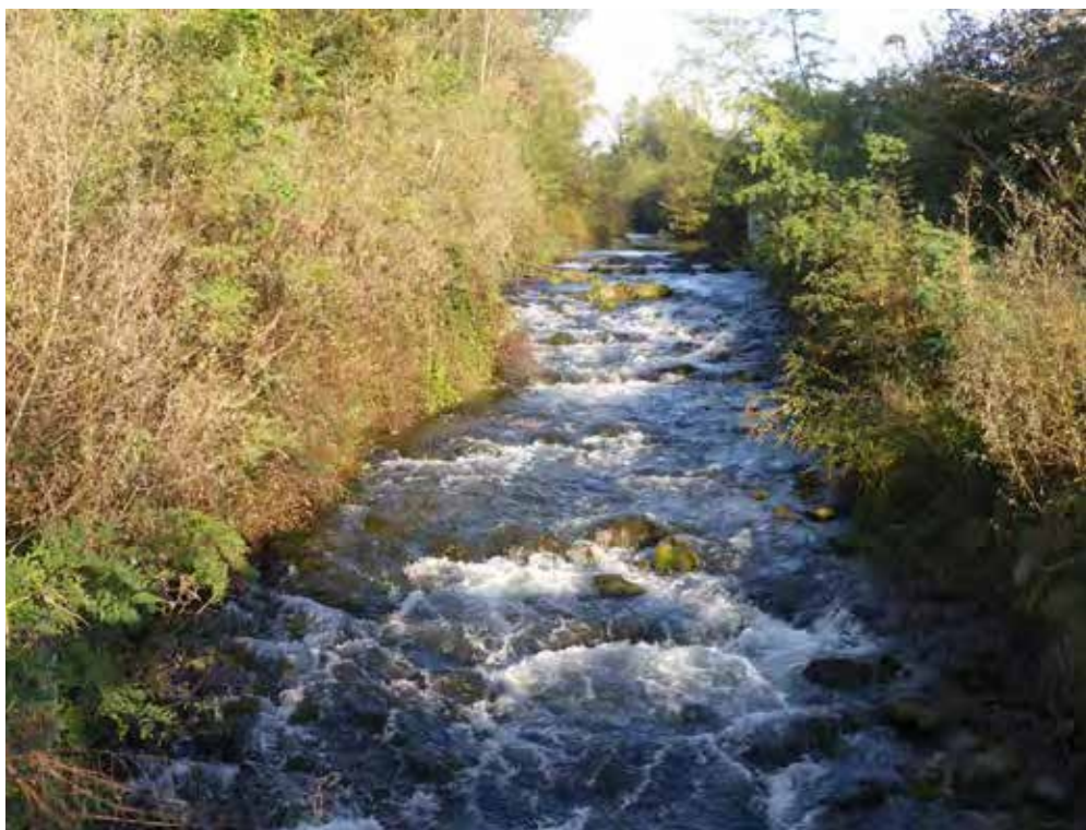
Figura 2.16: esempio di rampa in pietrame (Fosson Morto, Morimondo -MI)
