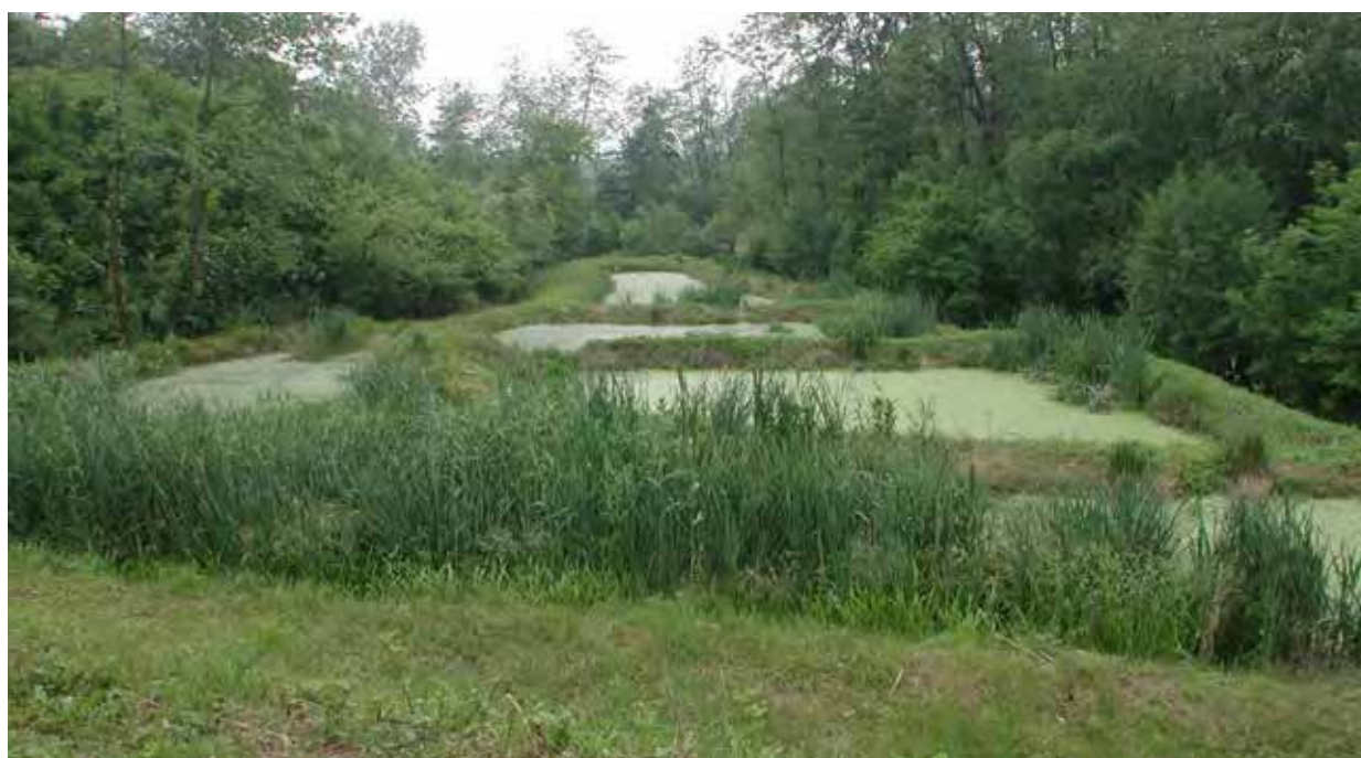
Figura 4.5: ecosistema filtro a flusso subsuperficiale
