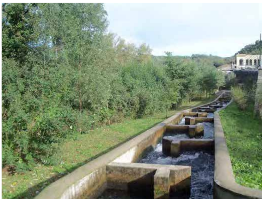
Figura 2.15: esempio di un passaggio a bacini successivi (Panperduto, Somma Lombardo -VA)
