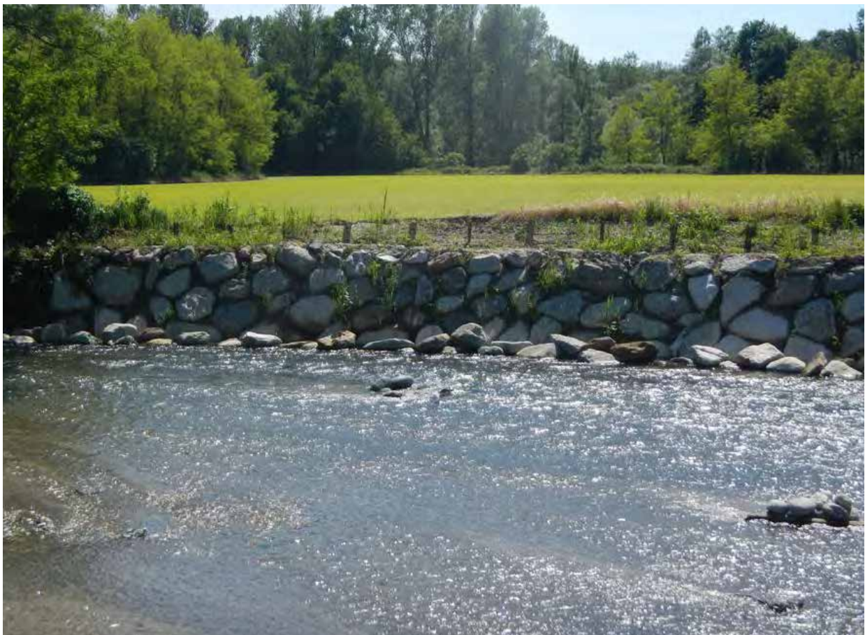
Figura 3.3: esempio di posa di massi al piede di una scarpata (Fosson Morto, Morimondo - MI)
