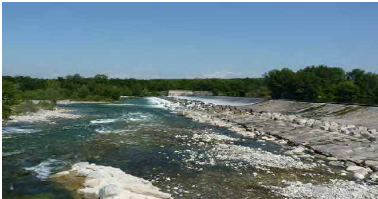
Figura 2.1: sbarramento della centrale di Panperduto
