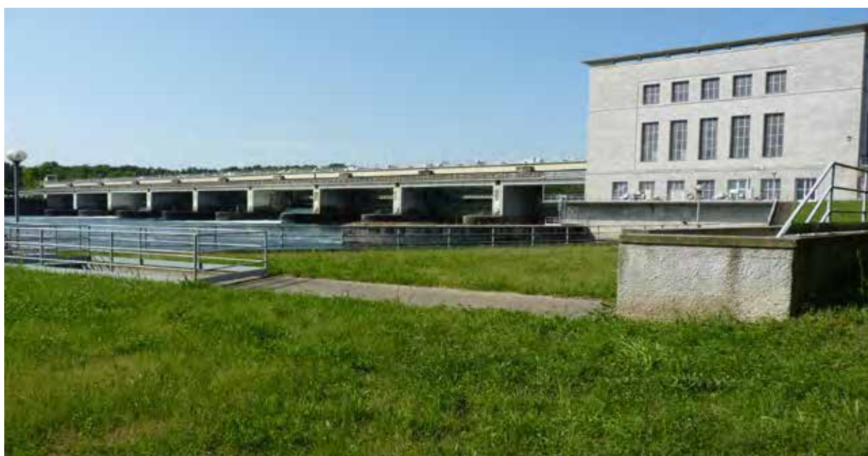
Figura 2.2: Diga di Porto della Torre
