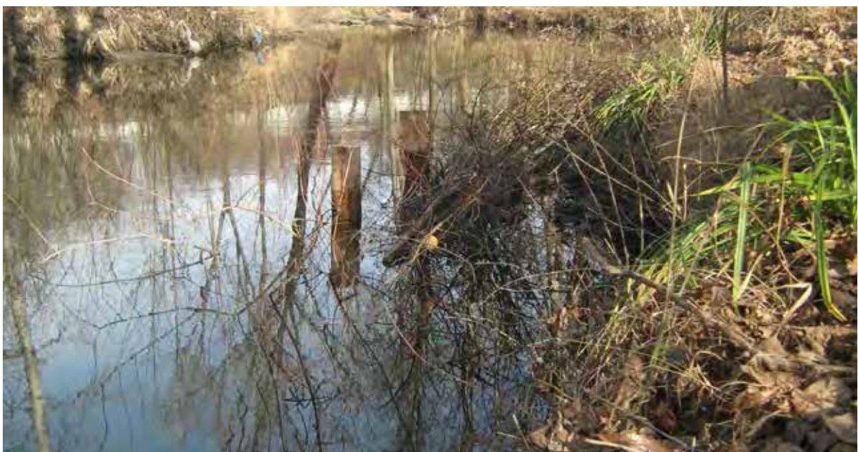
Figura 4.7: esempio realizzato di rifugi spondali con tronchi e ramaglia (Fiume Lambro, Merone - CO)
