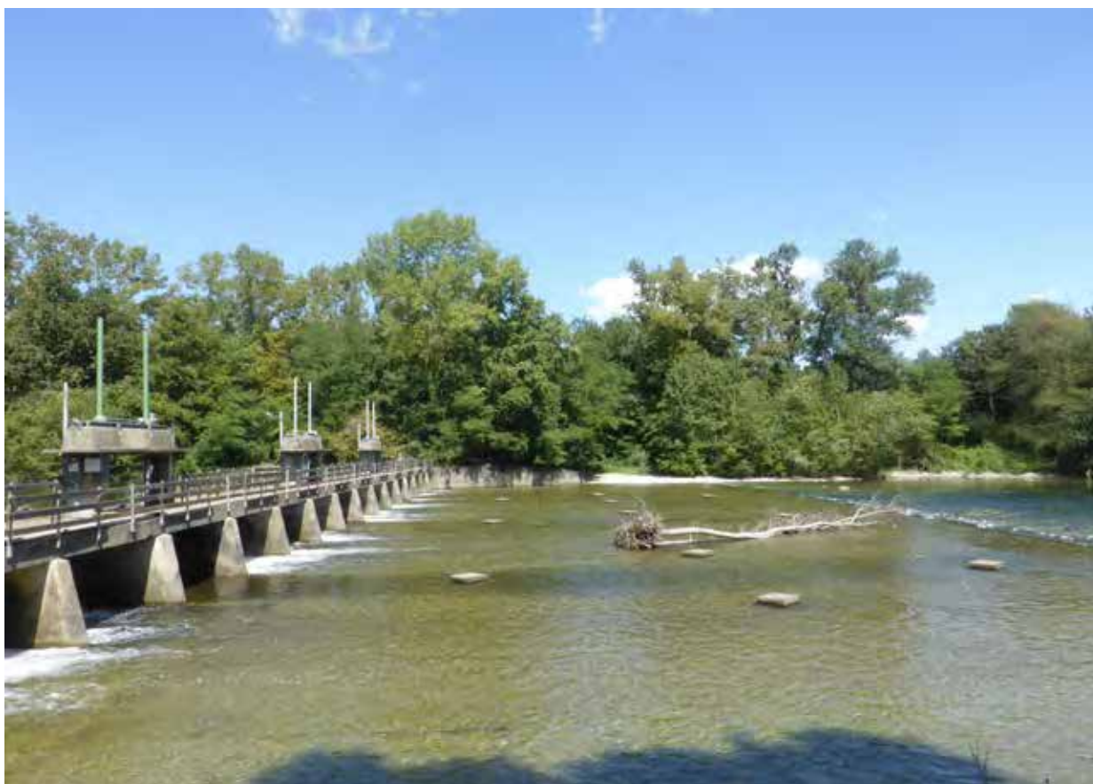
Figura 2.7: lo sbarramento in testa al Canale Treccione, visto da valle, in sponda destra (agosto 2016)
