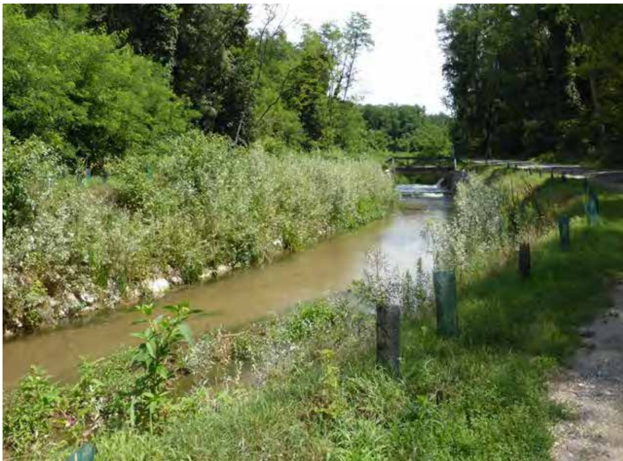
Figura 3.2: sponda consolidata attraverso una scogliera in massi rinverdita (Fosson Morto, Morimondo - MI)
