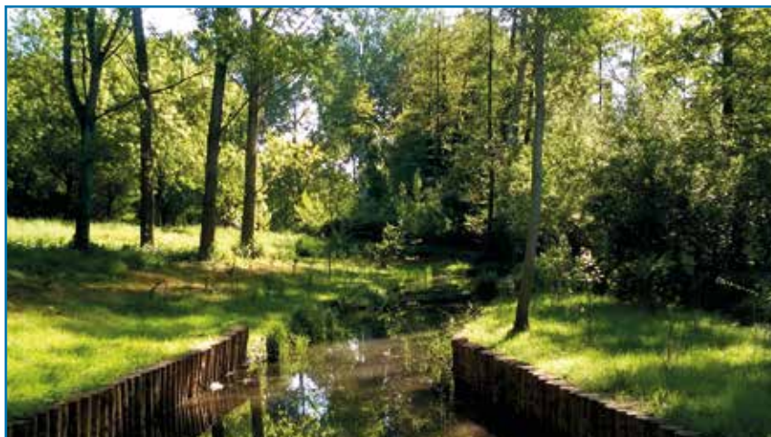
Figura 16 - Consolidamento della testa del fontanile.
