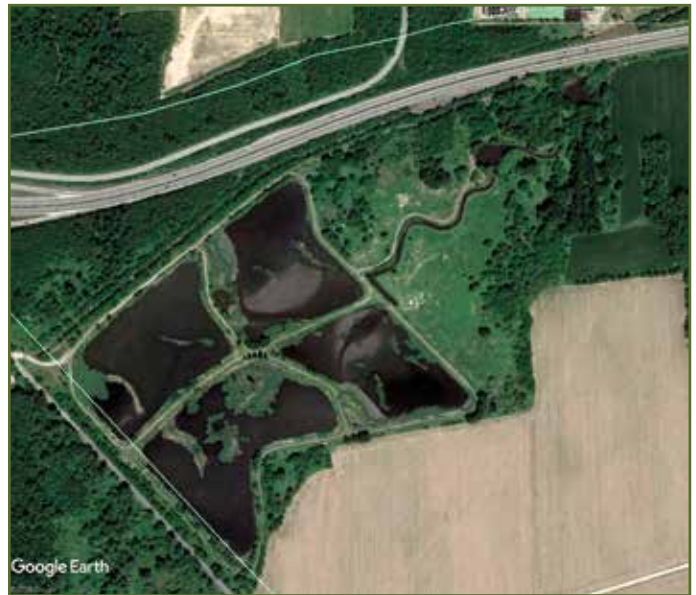
Figura 6.1 - Vasche di fitodepurazione a Sant'Antonino.
