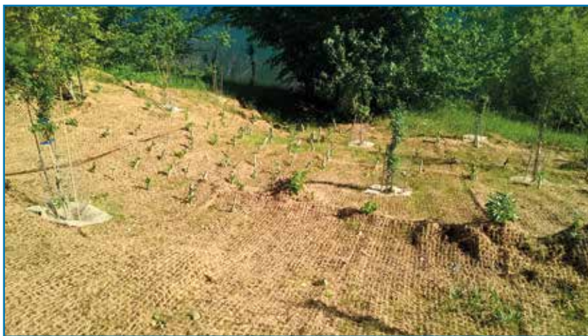
Figura 15 - Particolare di scarpata consolidata con ricaccio vegetativo delle talee di salice.
