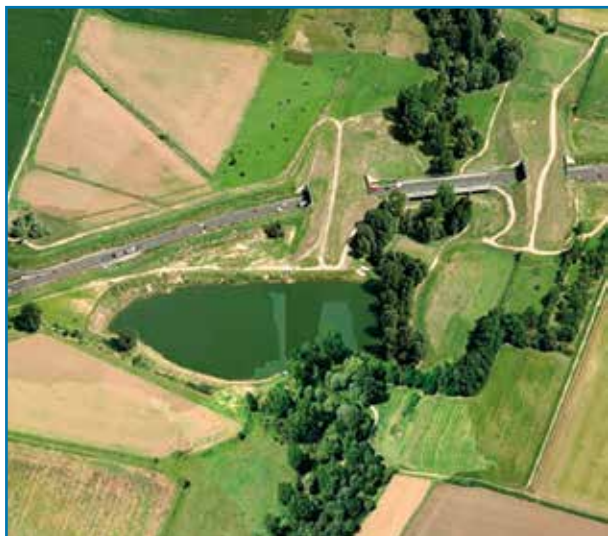
Figura 6 - Lago di cava a ridosso della Tangenziale nord.
