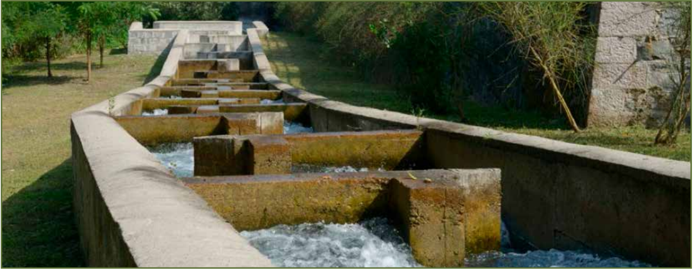
Figura 5.1 - Scala di risalita per pesci realizzata in corrispondenza della diga di Panperduto (Somma Lombardo).
