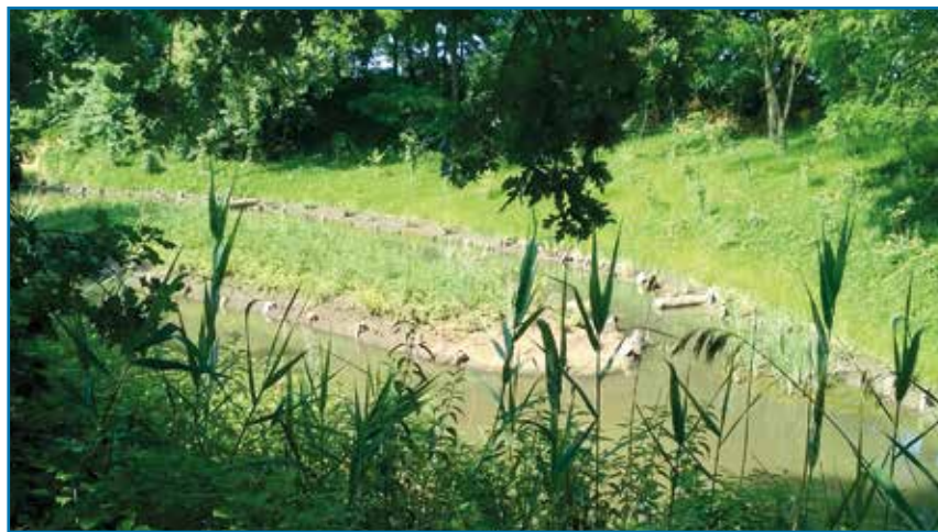
Figura 13 - Isolotto piantumato con idrofite radicate e sponde in fase di vegetazione.
