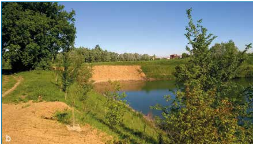
Figura 14 (a e b) - Panoramica degli interventi di consolidamento e rinaturalizzazione delle sponde.
