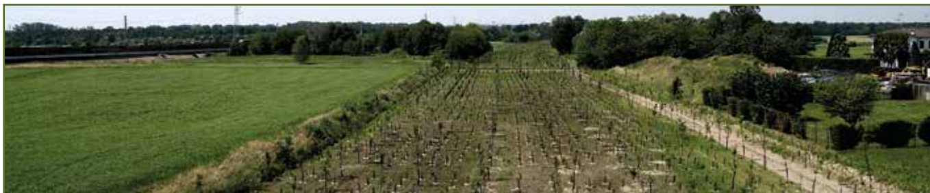
Figura 1.2 – Progetto di compensazione a seguito della realizzazione del nuovo tratto di autostrada e della demolizione del sedime esistente.
