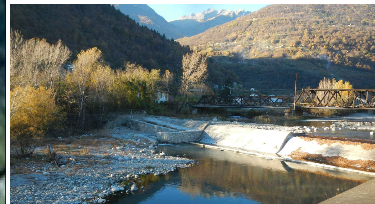
Illustrazione di un passaggio per pesci realizzato sul Torrente Masino nel Comune di Ardenno.
