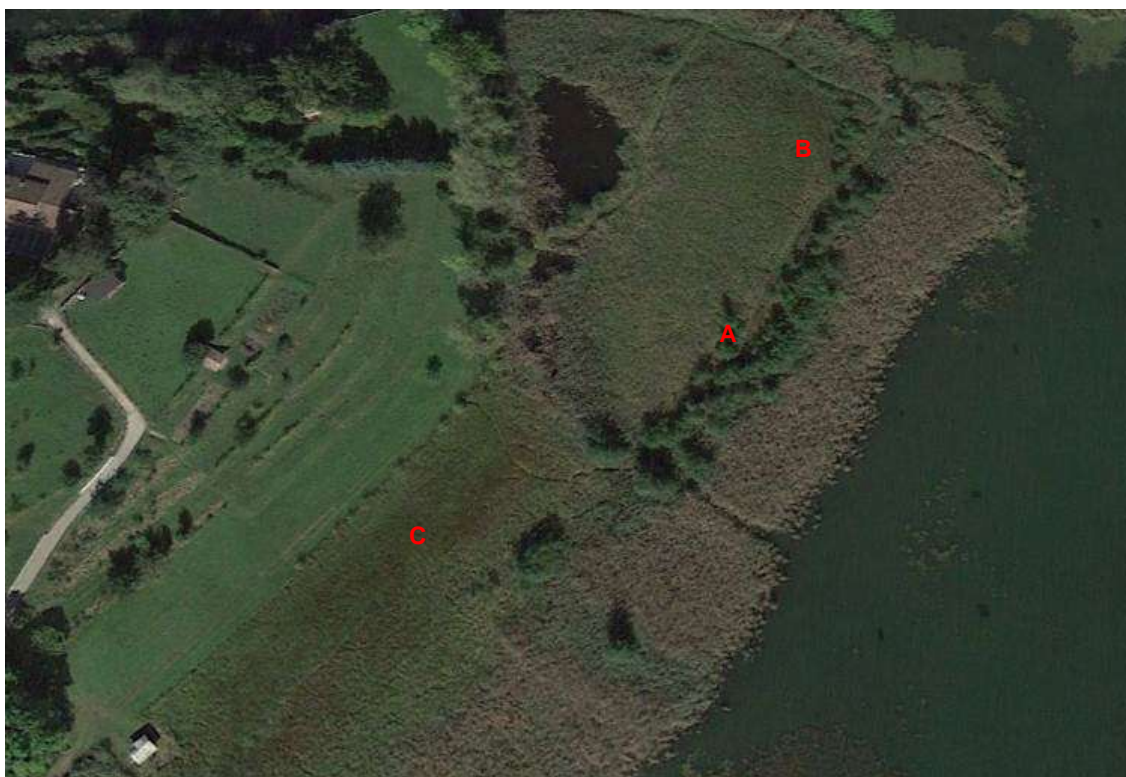
Figura 2.9: Localizzazione degli interventi effettuati nel sito n°2 Lago di Annone. Le lettere rimandano all'elenco puntato nel testo. Immagine da Google Earth Pro (04.10.2016).
