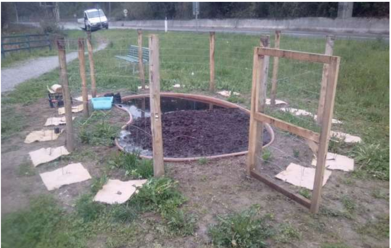
Figura 4.10. Fasi della realizzazione del giardino acquatico (foto R.Ceriani).
