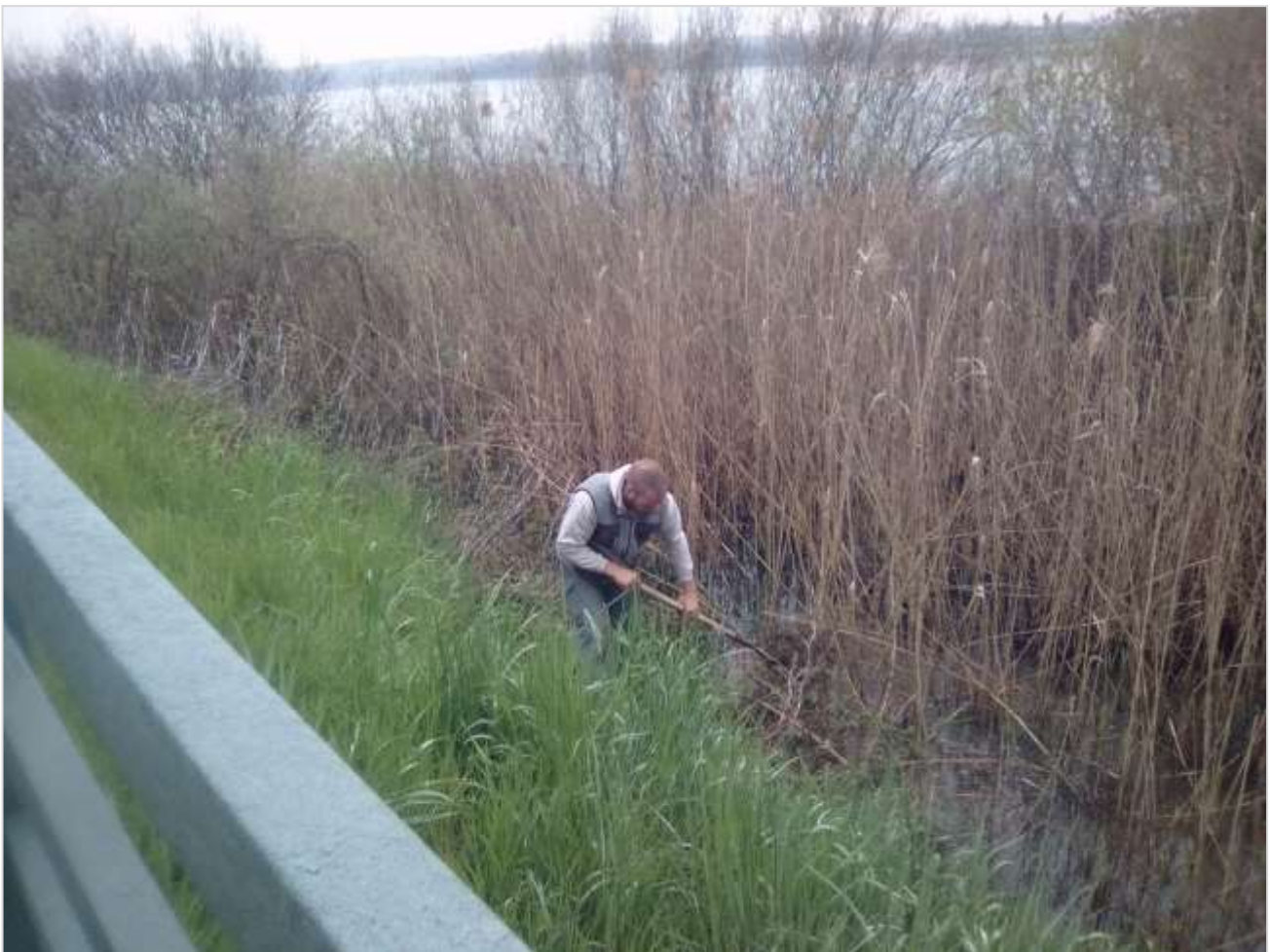
Figura 4.9. Preparazione della scarpata fronte lago prima della messa a dimora delle piante a fiore (foto R.Ceriani).
