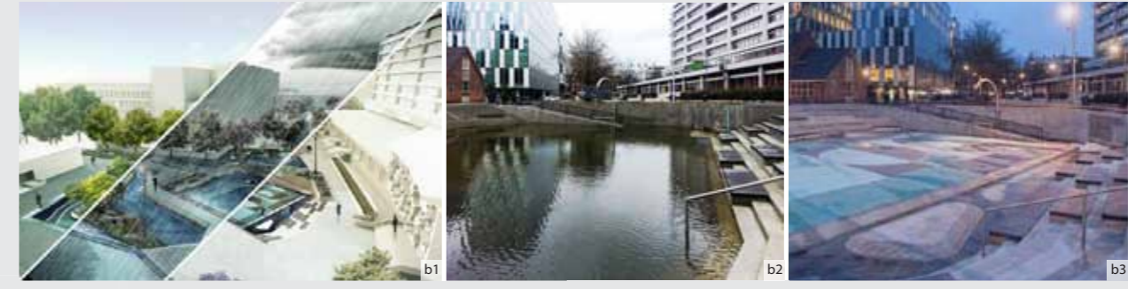
Bentheplein water square, Rotterdam (NL), De Urbanisten (capacità di raccolta acqua: 1700mc)
