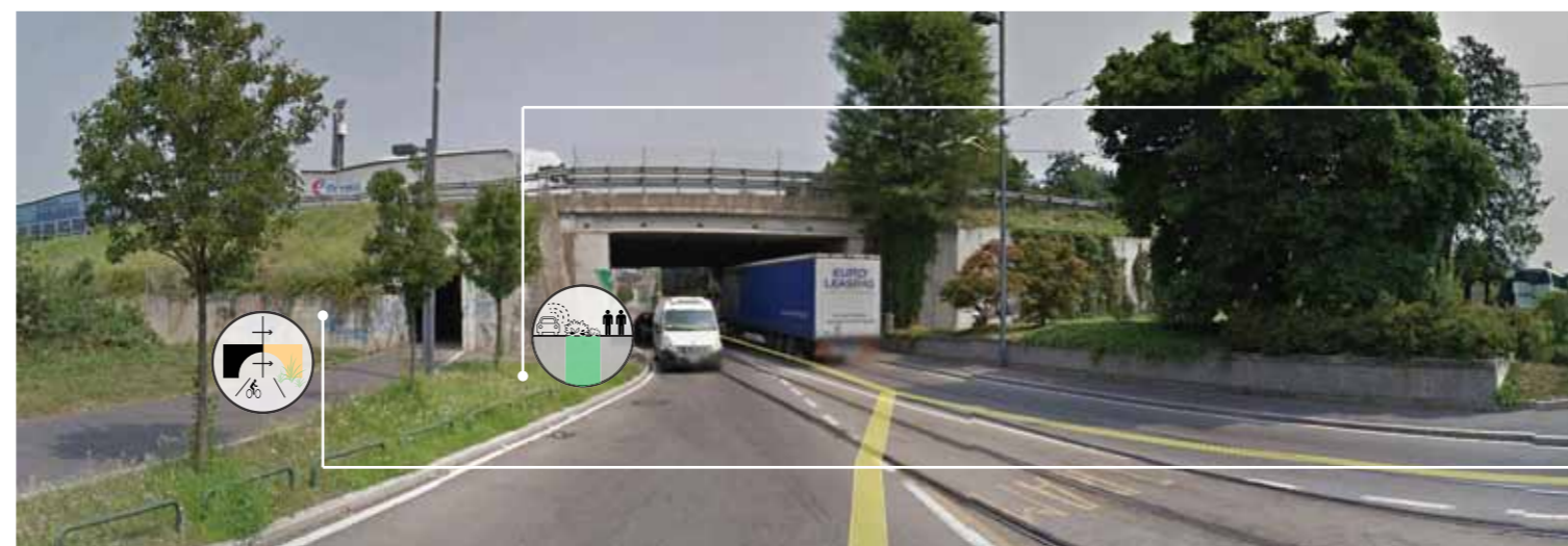
13 Via Massimo Gorki in corrispondenza dell'attraversamento dell' A4
