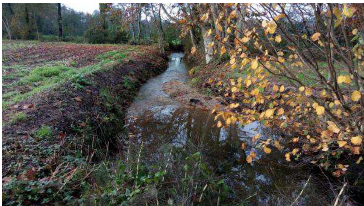
Figura 2: situazione ante operam tratto Torrente Boccogna con presenza di detriti in alveo
