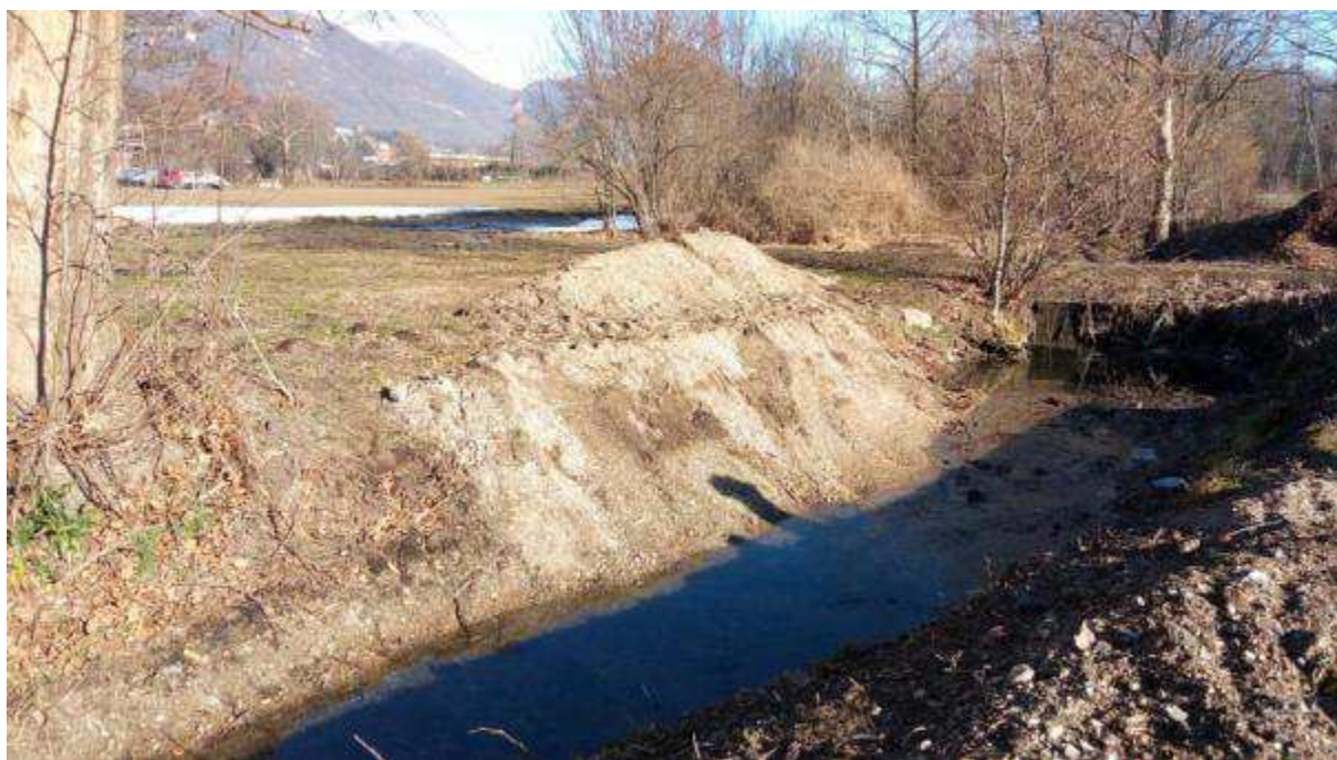
Figura 3: situazione post operam tratto Torrente Boccogna con detriti rimossi
