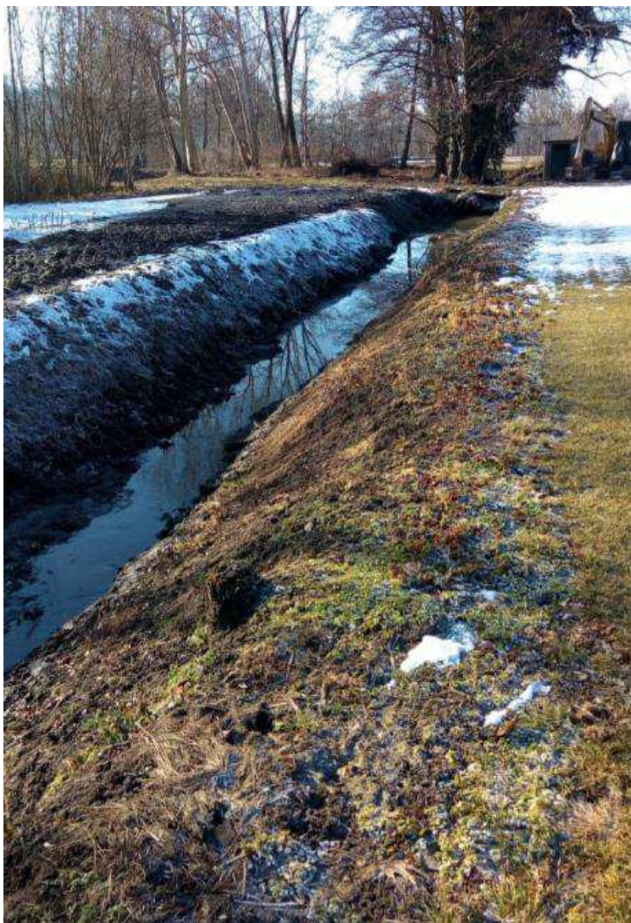
Figura 7: situazione post operam canale che collega via Barzaghi con Torrente Boccogna con detriti rimossi e depositati lungo il piano di campagna
