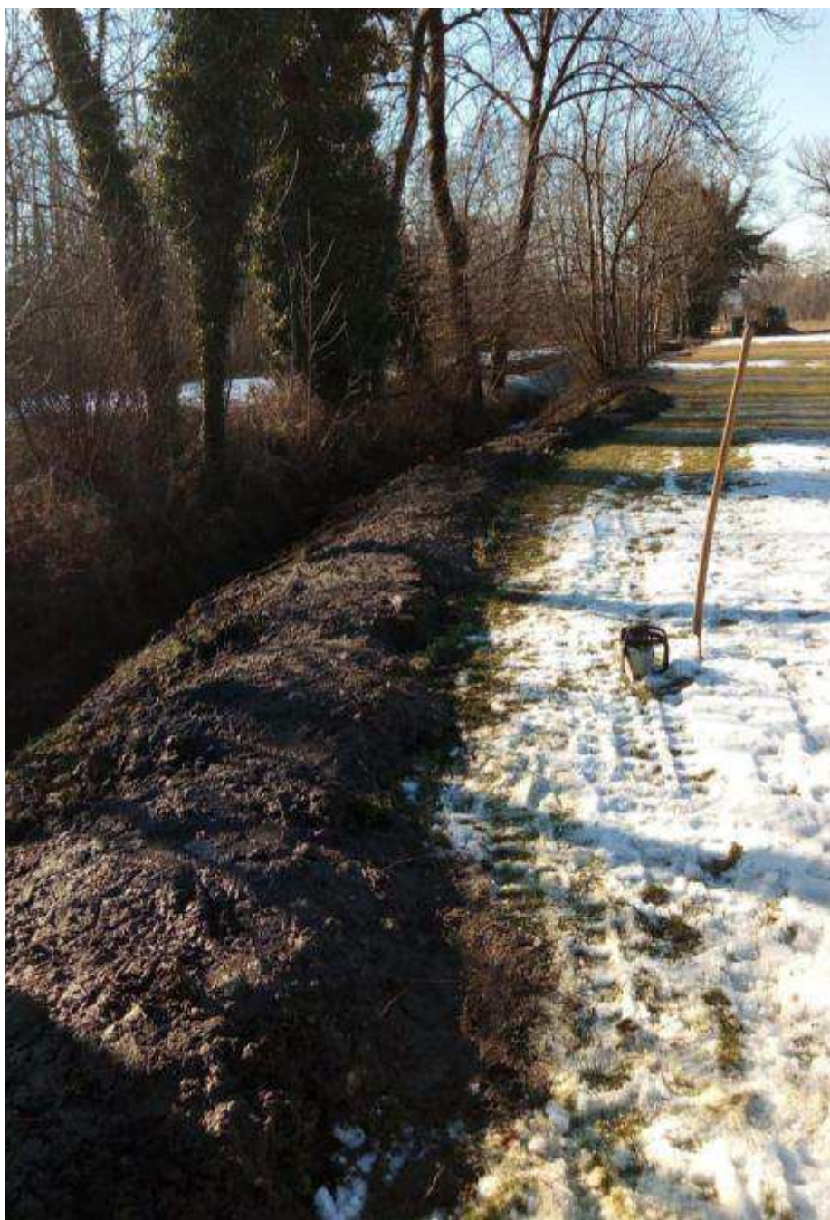
Figura 5: situazione post operam canale che collega via Barzaghi con Torrente Boccogna con detriti rimossi e depositati lungo il piano di campagna
