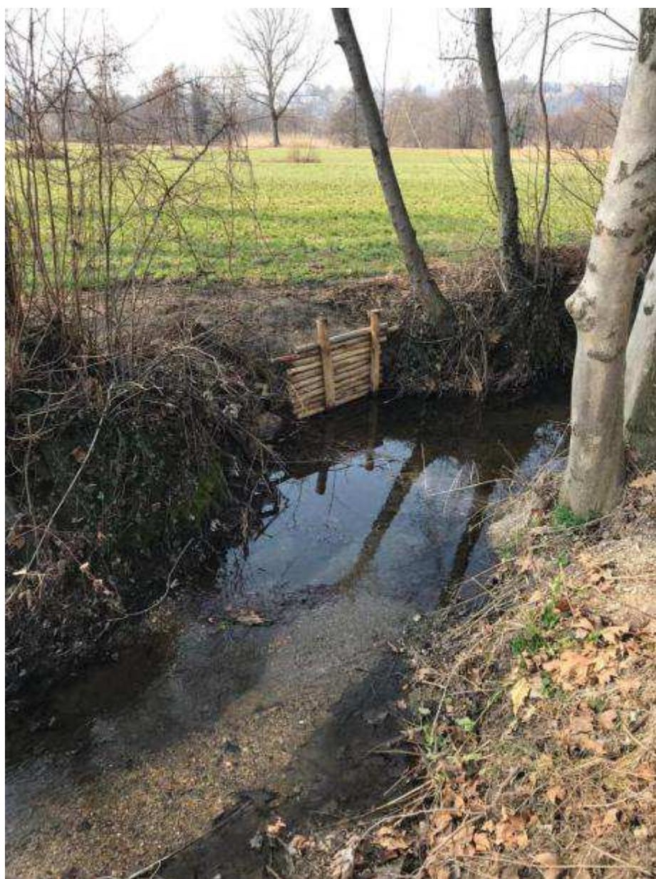
Figura 10: viminata viva Torrente Boccogna
