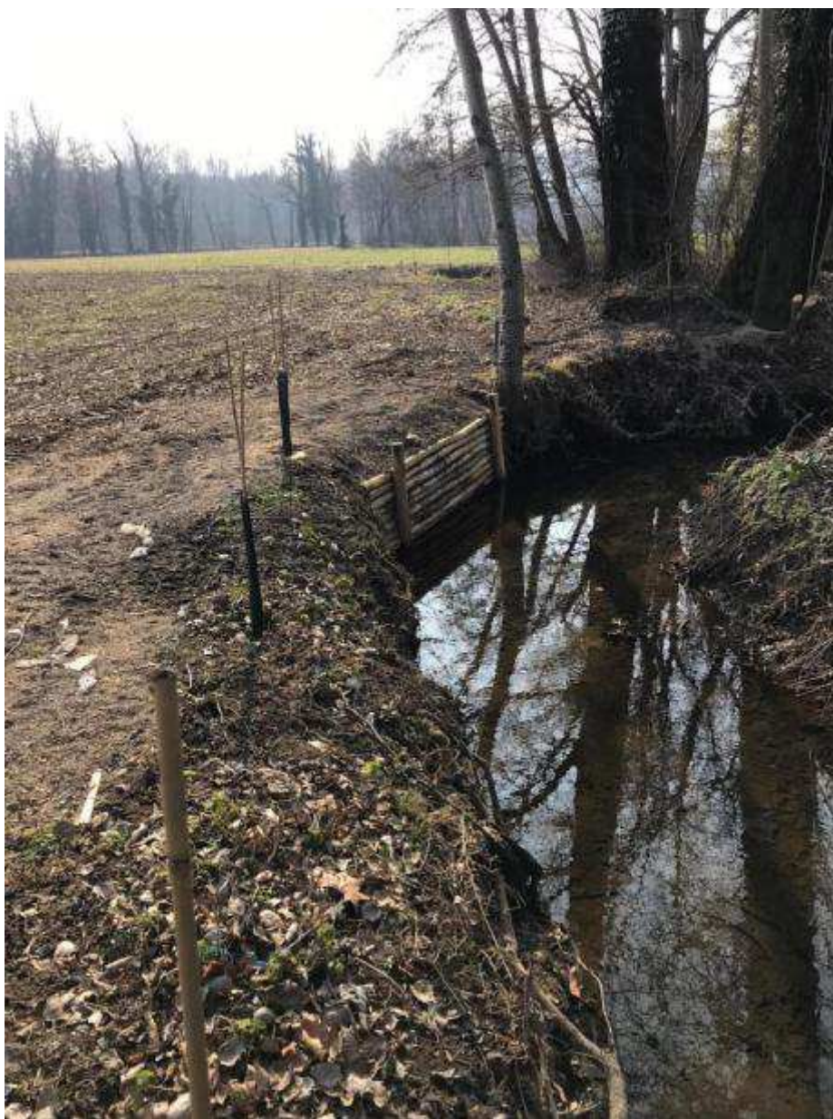
Figura 9: viminata viva Torrente Boccogna
