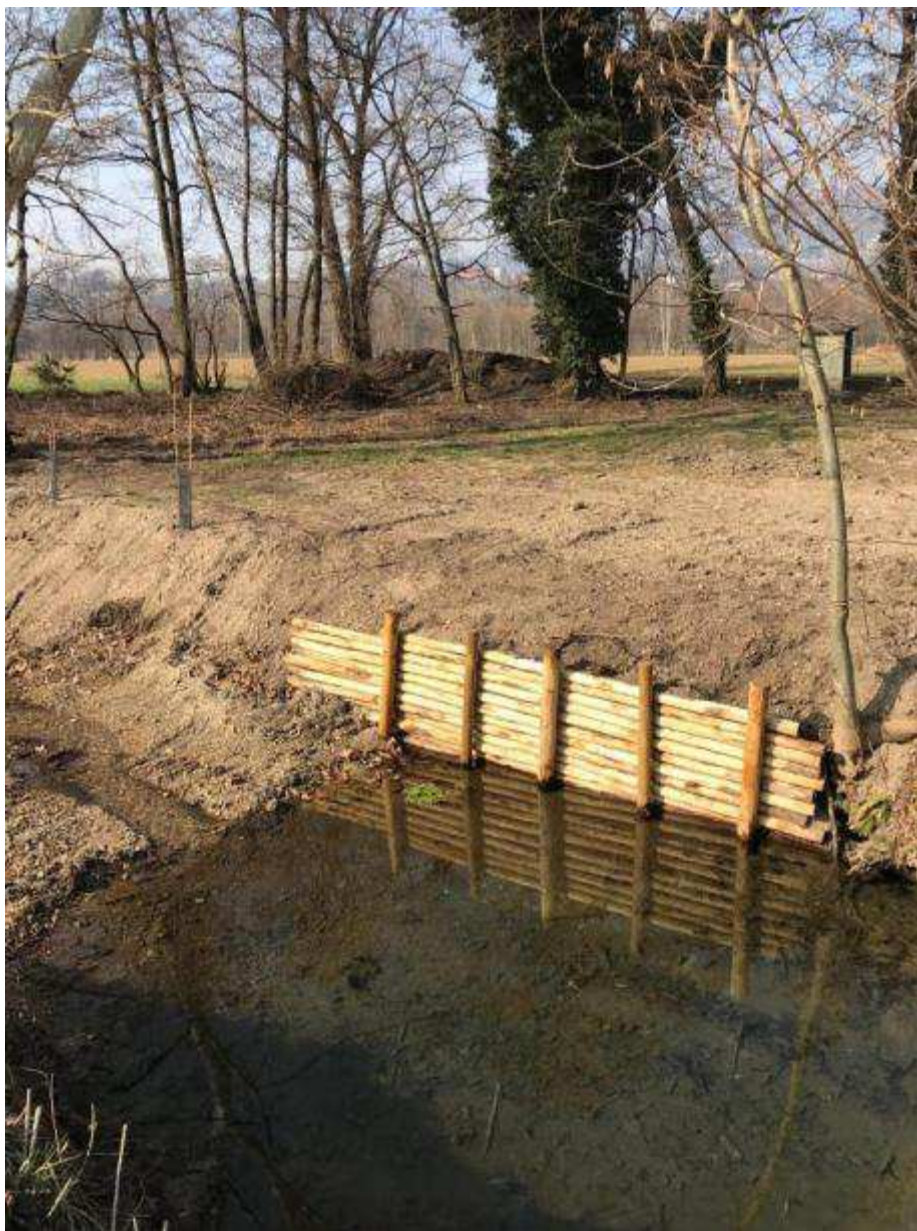
Figura 8: viminata viva Torrente Boccogna
