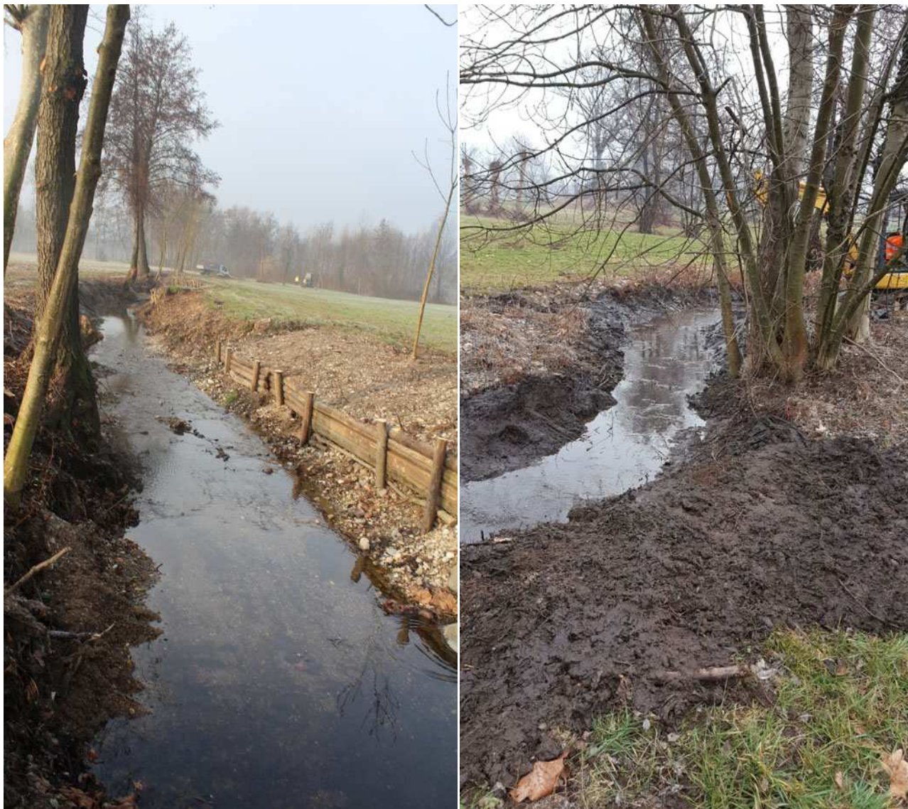
Lavori realizzati lungo le rogge Maneggio e Tre Ponti
