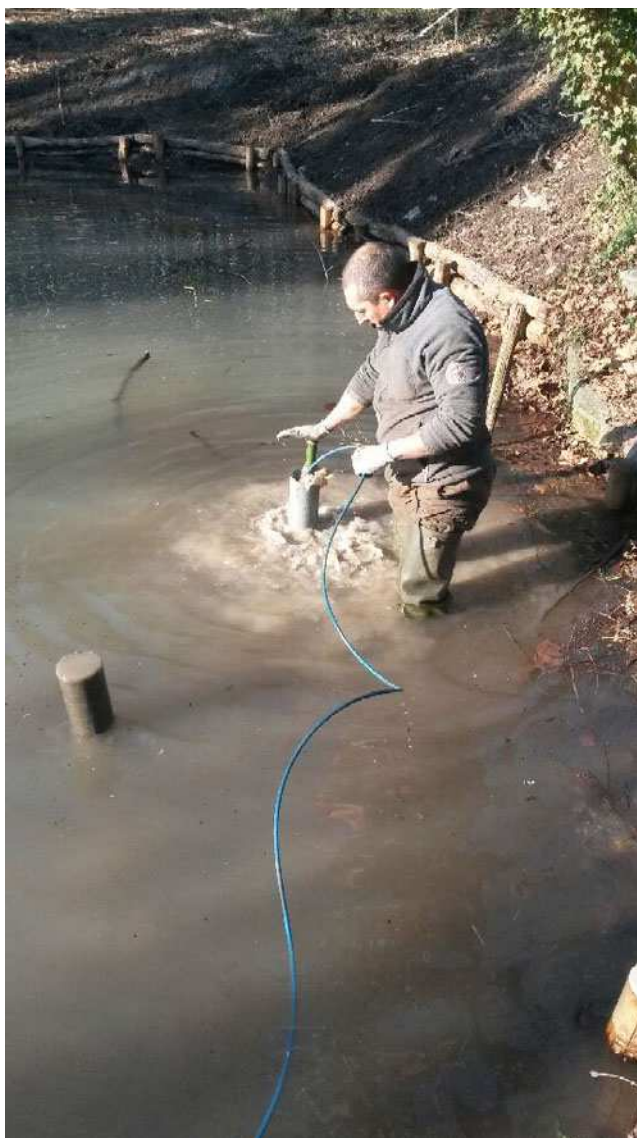
Lavori di infissione dei pali Norton (a sinistra) e risultato finale (a destra).
