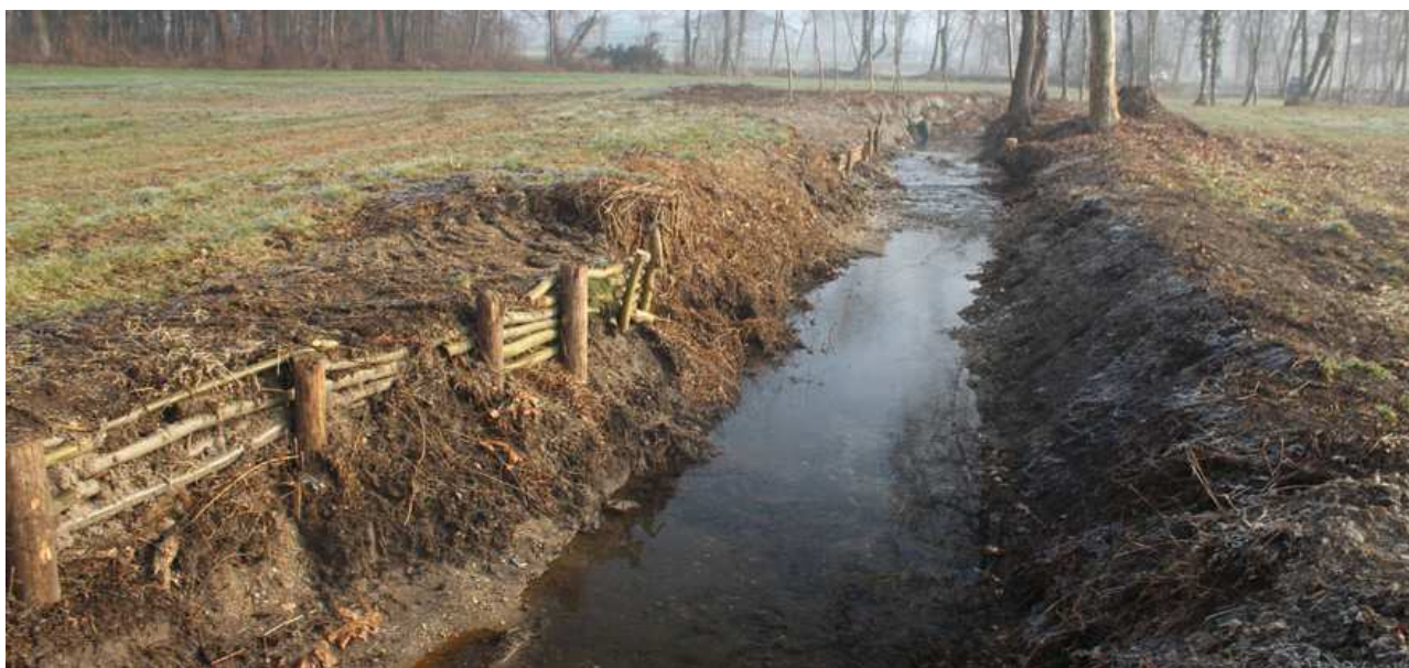
Tipologico delle opere realizzate: apertura dei canali di deflusso e realizzazione di opere di consolidamento spondale con ingegneria naturalistica
