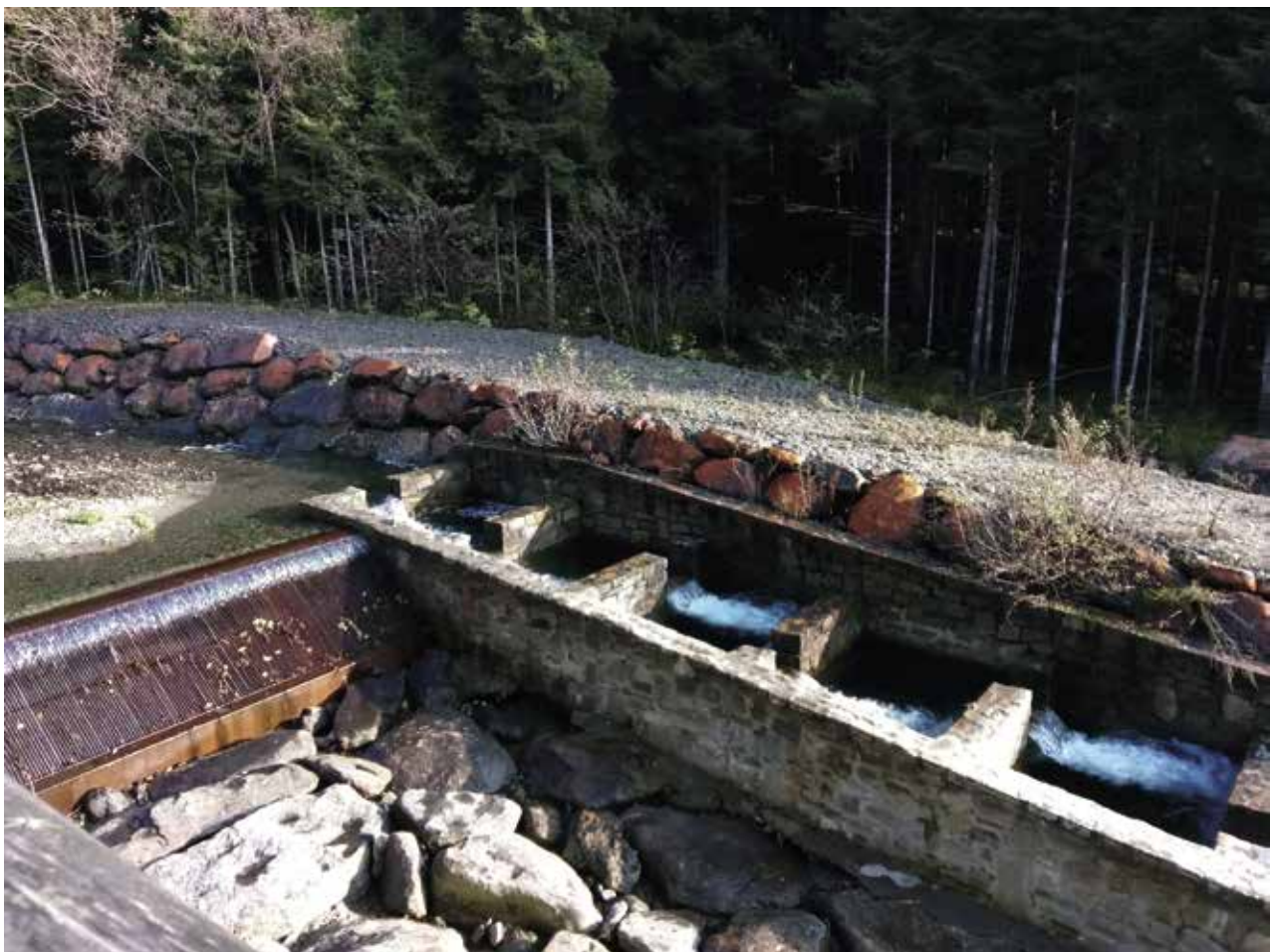
Scala di risalita del pesce sul Torrente Salarno a Savio dell'Adamello.
