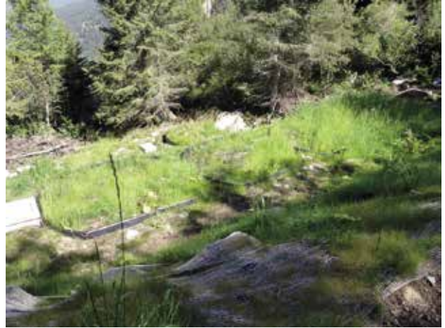
Scavo del bacino.
