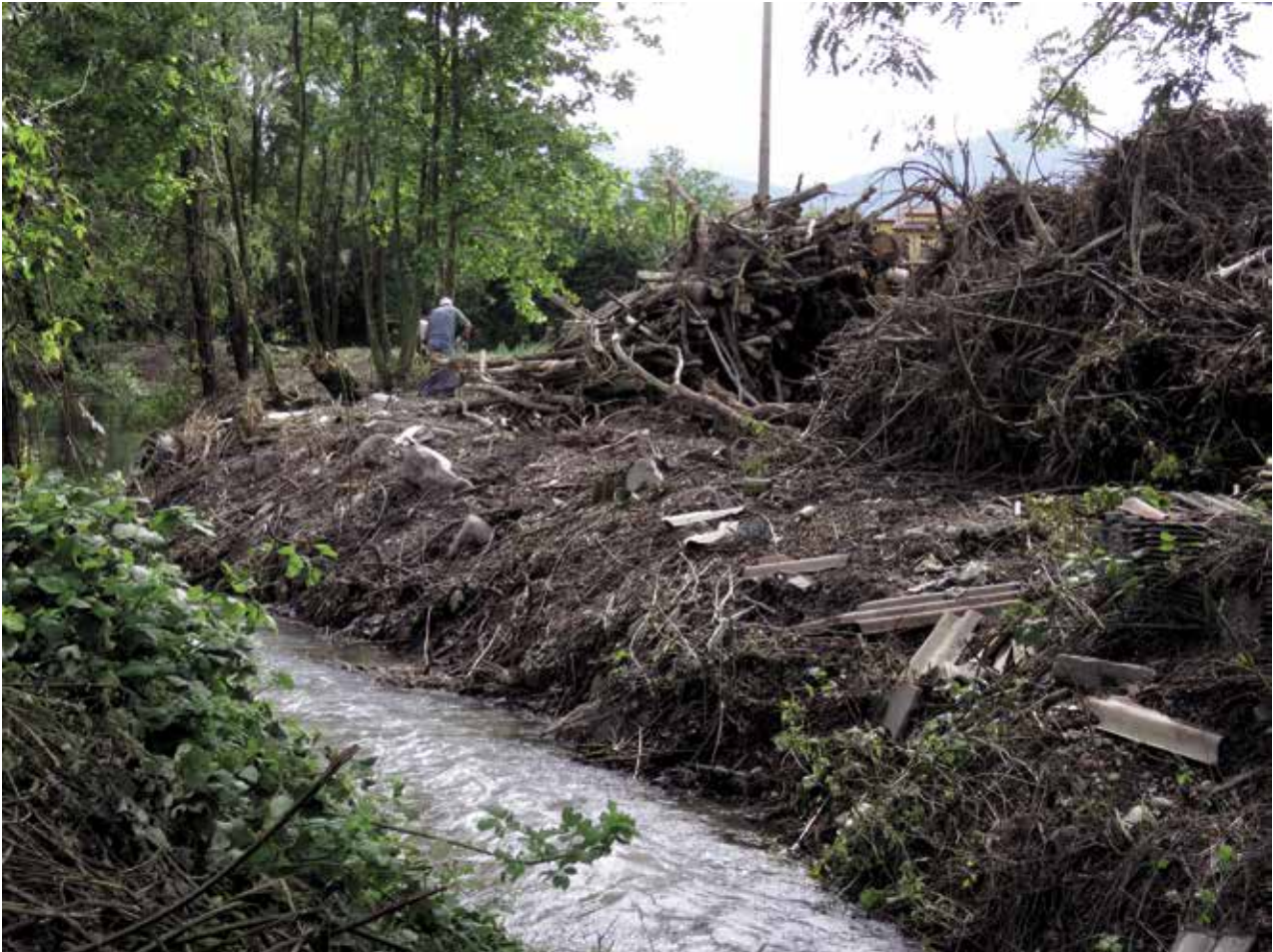
Tratto di realizzazione del Sentiero Fluviale nel Comune di Costa Volpino. Raccolta e smaltimento dei rifiuti.
