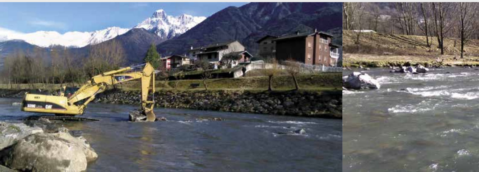
Realizzazione dei cluster di diversificazione fluviale nei comuni di Losine, Niardo e Braone.
