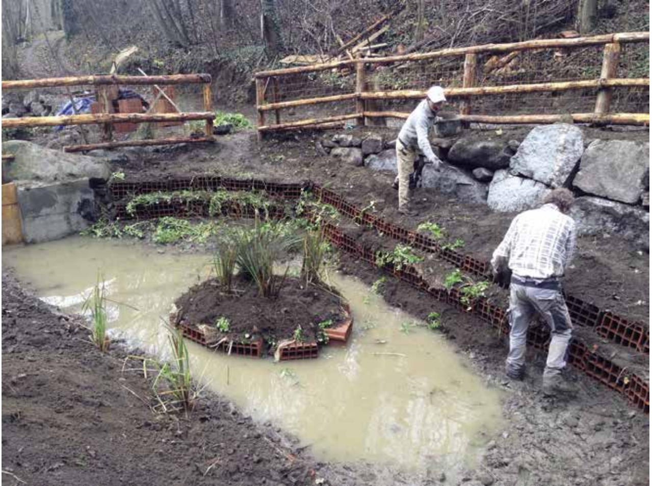
Stagno di Braone: l'esecuzione dei lavori.
