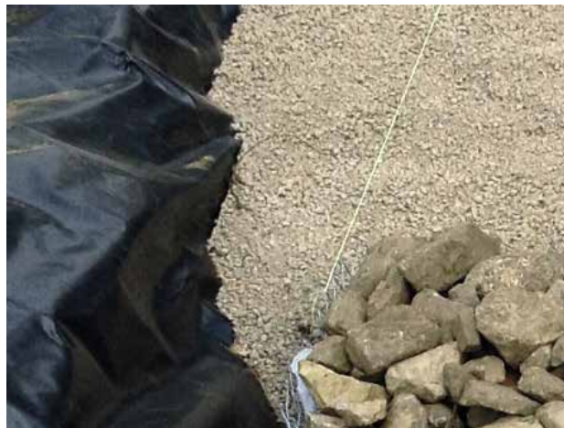
Dettaglio dello strato di zeolite posata sopra lo strato impermeabilizzante.
