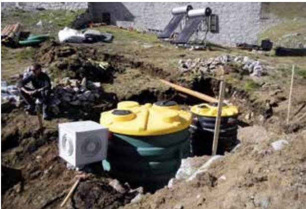
Realizzazione dei trattamenti preliminari.
