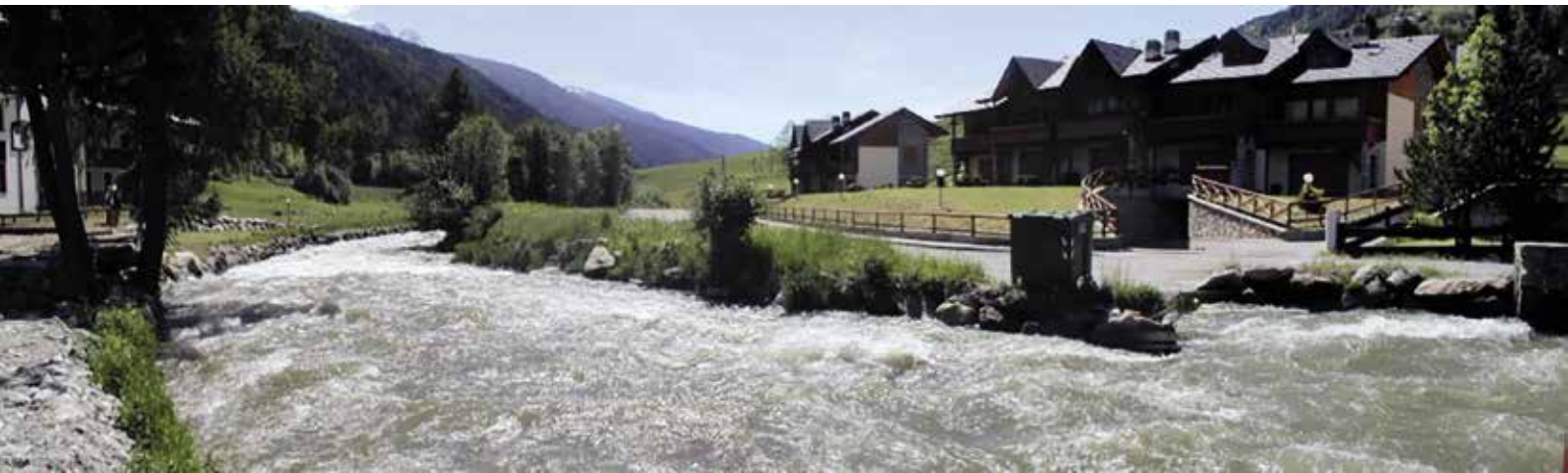
Figura 13 – Ponte di Legno, Via Ettore Calvelli. Sulla sponda destra del Fiume Oglio, a pochi metri dal corso d'acqua, sono state realizzate villette a schiera con garage in sotterranea. Un innalzamento anche solo 50-60 cm del livello delle acque comporterebbe il riempimento dei garage (la cui rampa di ingresso sembra un chiaro invito..), con evidenti gravi danni per le autovetture dei proprietari e magari anche vittime.
