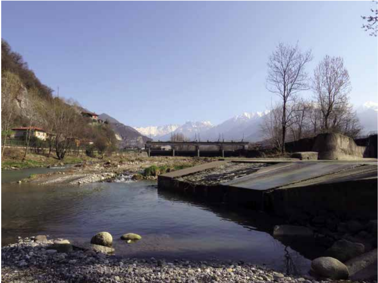
Presa sul Fiume Oglio ex Silva, ora D.K.W. a Esine.
