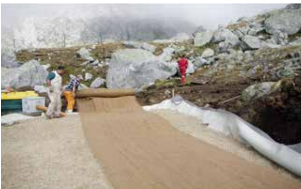
Posa di geotessuto di separazione dei substrati.
