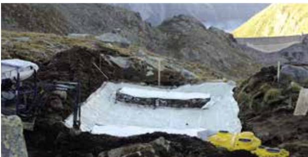
Impermeabilizzazione del fondo bacino con telo in PVC.
