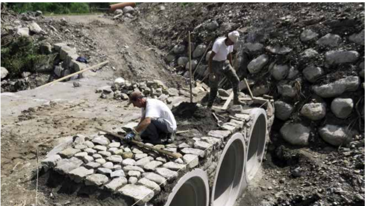
Lavori di realizzazione di attraversamento dell'Ogliolo di San Carlo, affluente del Fiume Oglio, in Comune di Costa Volpino.
