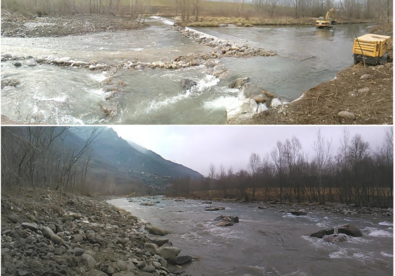
**Figura 2. In alto intervento di deframmentazione di una briglia a Sellero, in centro e in basso interventi di diversificazione ambientale mediante la posa di massi in alveo**
