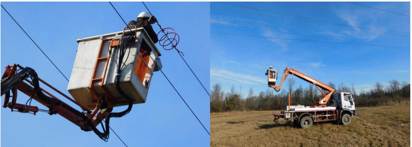
*Intervento di messa in sicurezza di una linea elettrica nella Torbiera del Gaggio tramite posa di spirali; a sinistra la posa di una spirale; a destra il mezzo utilizzato per la posa.*
