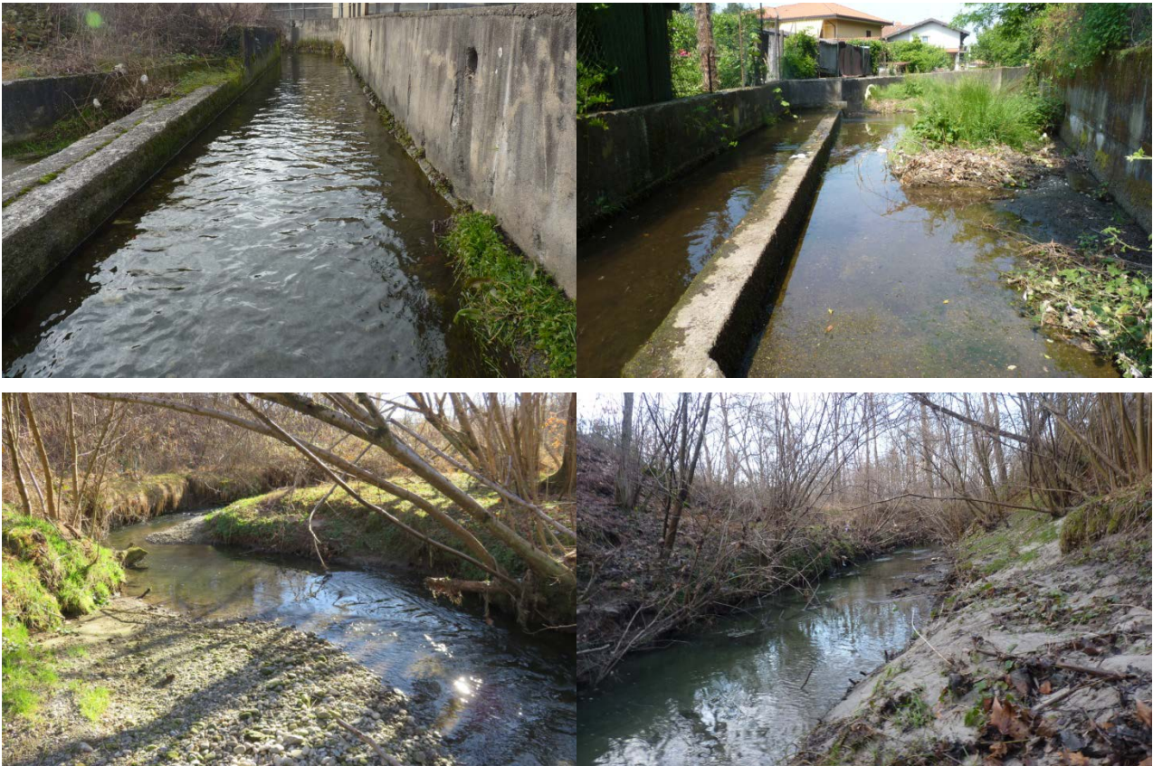
Figura 1. Torrente Acquanegra nell'abitato di Travedona Monate e a valle del depuratore di Travedona Monate
