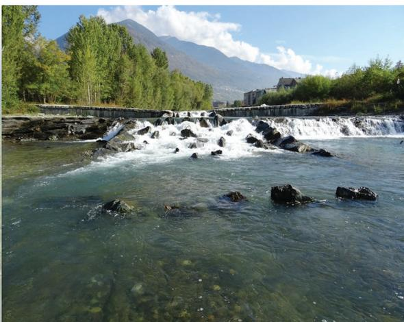
FIG.7: RAMPE IN PIETRAMME REALIZZATE SUL TORRENTE MALLERO
