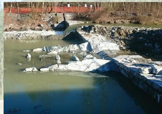
FIG.9: RAMPE IN PIETRAMME REALIZZATE SUL TORRENTE MALLERO
