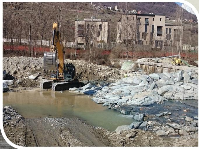
FIG.14: COSTRUZIONE DELLA RAMPA IN PIETRAMÈ
