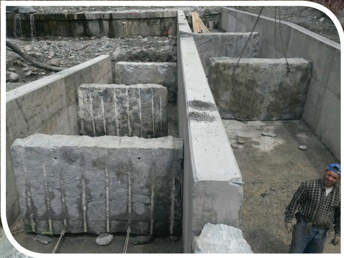
FIG.13: REALIZZAZIONE DEL PASSAGGIO PER PESCI A BACINI SUCCESSIVI
