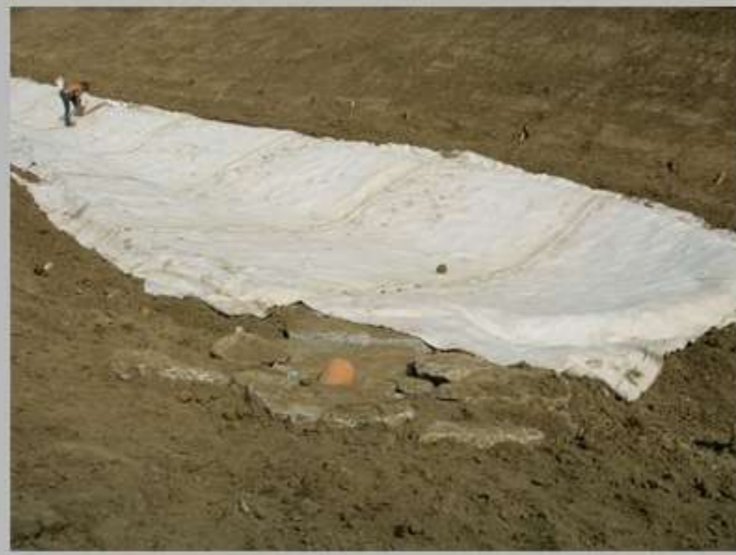
Fase di realizzazione della vasca
