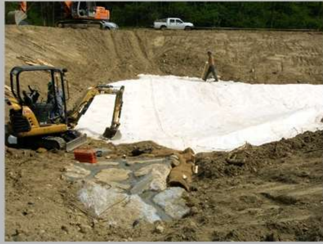
Fase di realizzazione della vasca
