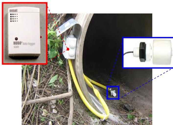
*Figura 2.1.17. Apparecchiatura livellostato (riquadro blu) – datalogger (riquadro rosso) nello scolmatore di Ponte Lambro in via Geret.*
