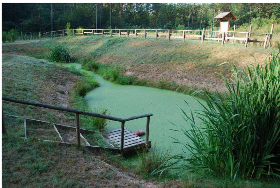
Figura 5 – Stagno artificiale facente parte dell'impianto di fitodepurazione di Pianbosco
