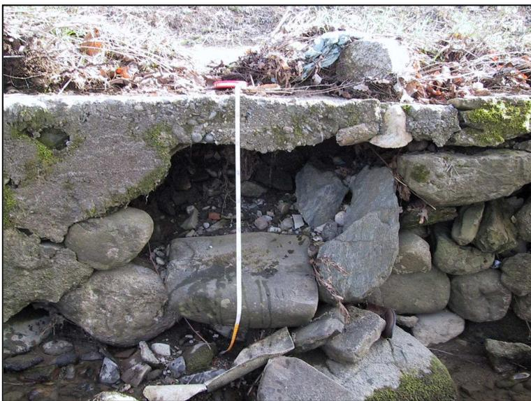
**FIG. 29** *Muro di sostegno lesionato in sponda sinistra*
