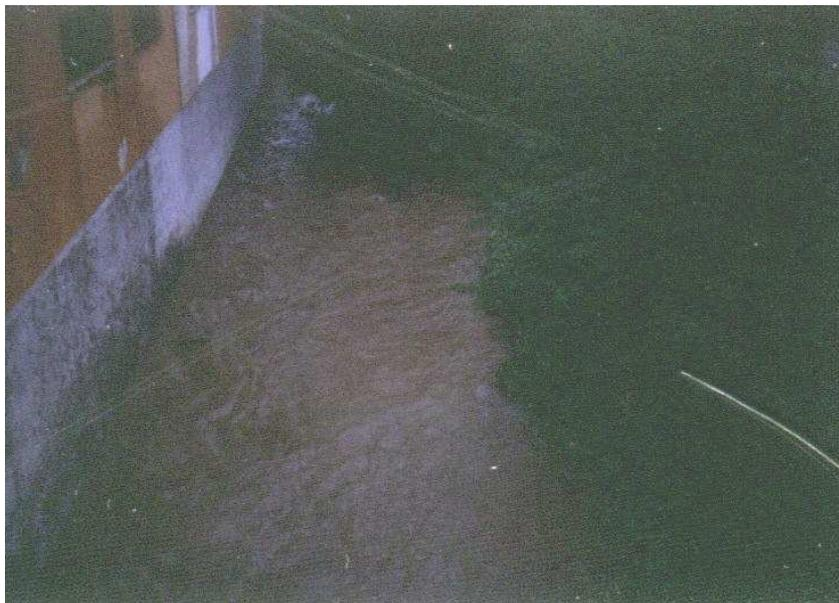
La portata di massima piena, in caso di precipitazioni intense, è risultata di  $25.46 \text{ m}^3/\text{s}$ , considerando una sezione bagnata massima di circa  $6.7 \text{ m}^2$  e una velocità dell'acqua di circa  $3.8 \text{ m/s}$ .
