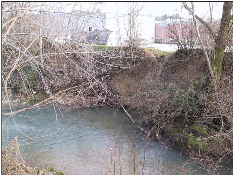
*FIG. 13 Erosione sponda sinistra – Comune di Olgiate loc.
