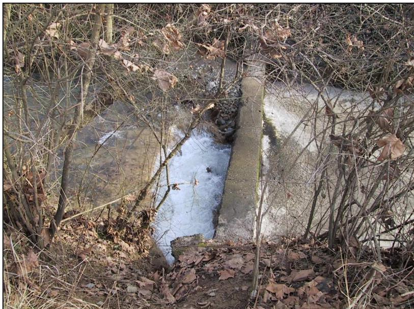
**FIG. 16** *Erosione briglia – Comune di Olgiate loc. Molino Cattaneo*
