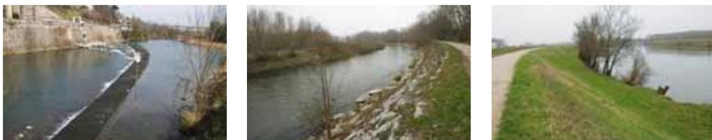
Figura 5 - Esempio di interruzione di continuità longitudinale (soglia a Palazzo) e laterale (difesa spondale presso Villachiera e argine presso Gazzuolo).
