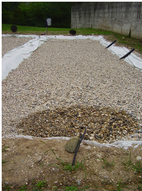
Figura 9 – Riempimento della vasca 1 durante la prova del 25 settembre 2007.
