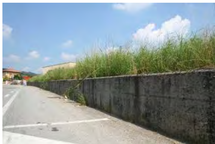
Particolare del muretto da deframmentare
