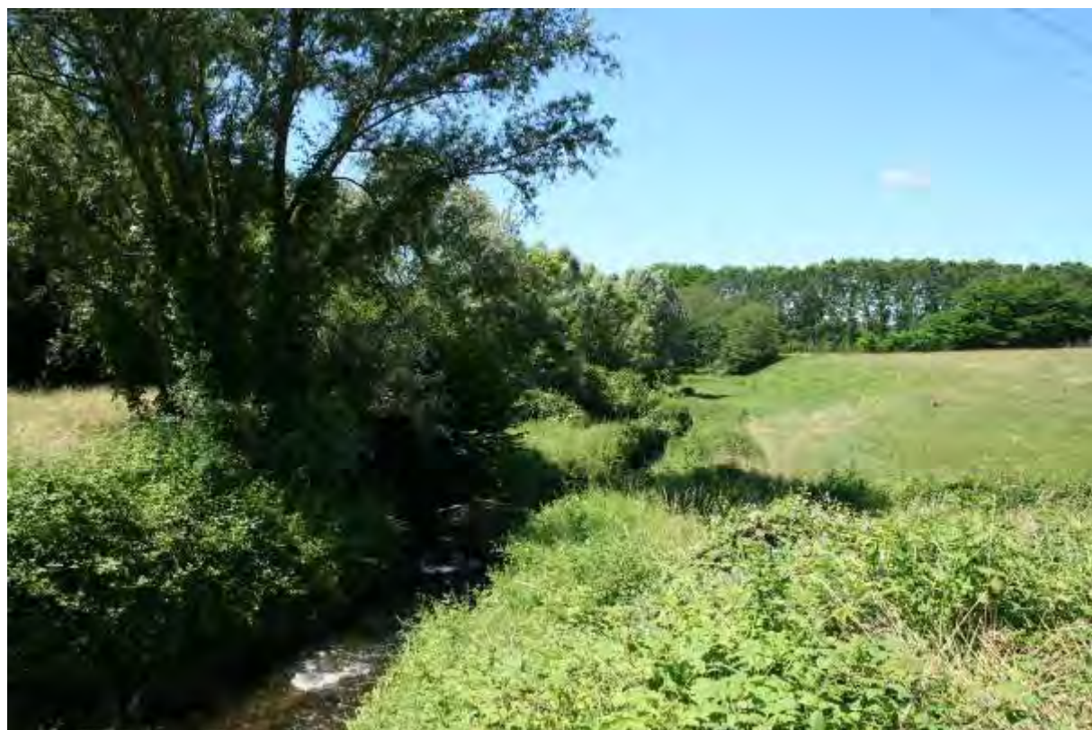
Il corso del torrente Strona a valle del ponte. Anche in questo caso si segnala la necessità di arricchimento della vegetazione arboreo-arbustiva ripariale
