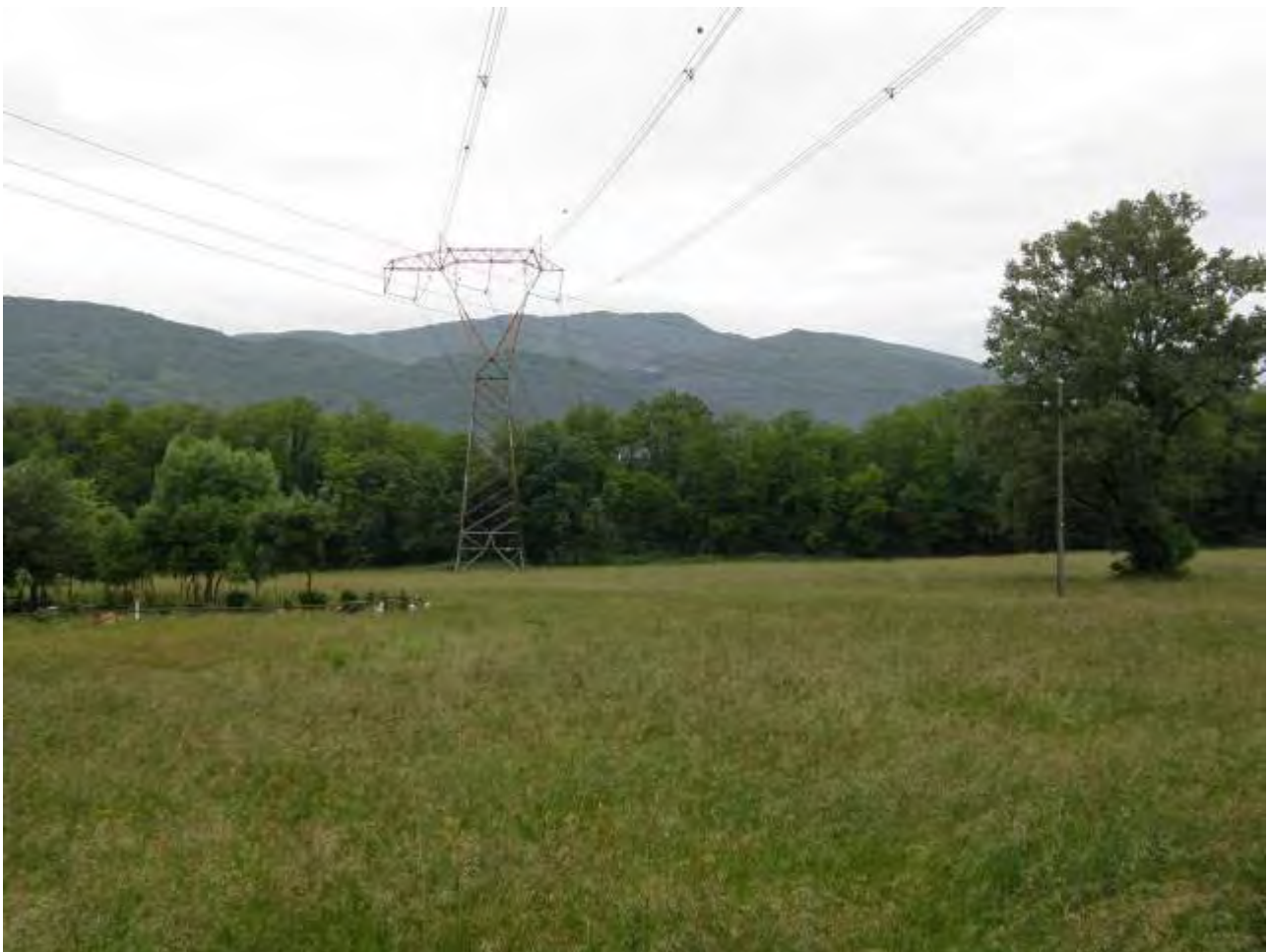
La linea dell'alta tensione che attraversa il varco.
