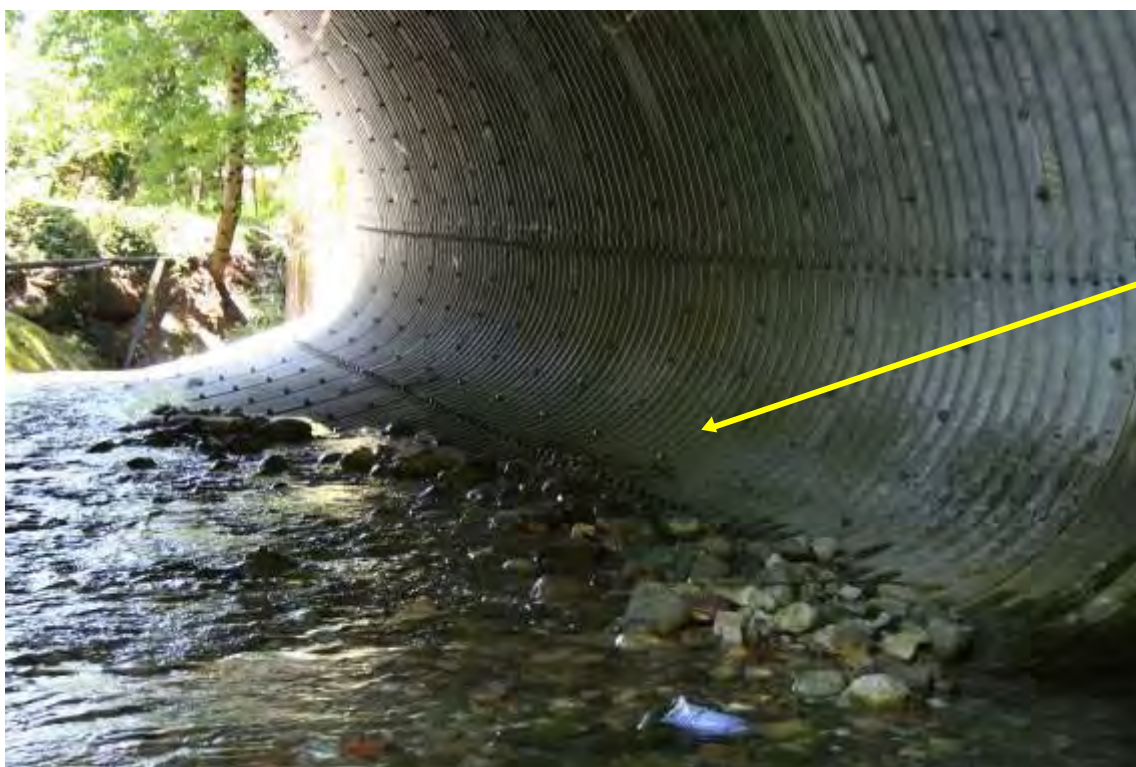
Ai lati del torrente l'apposizione di mensole favorirebbe il transito della fauna in caso di piene
