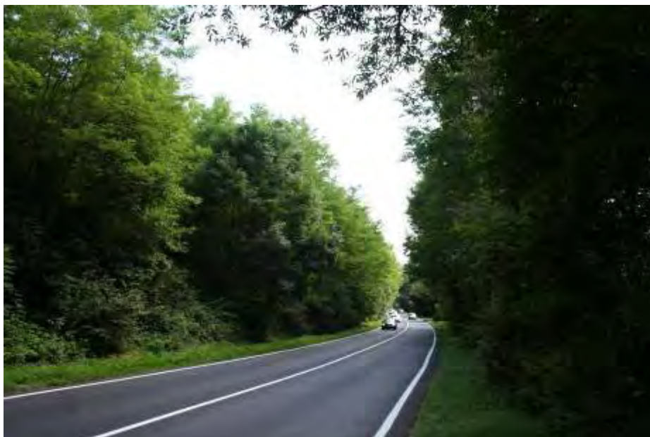
Punto in cui la S.P. 18 intercetta il varco, necessitante di sottopasso
