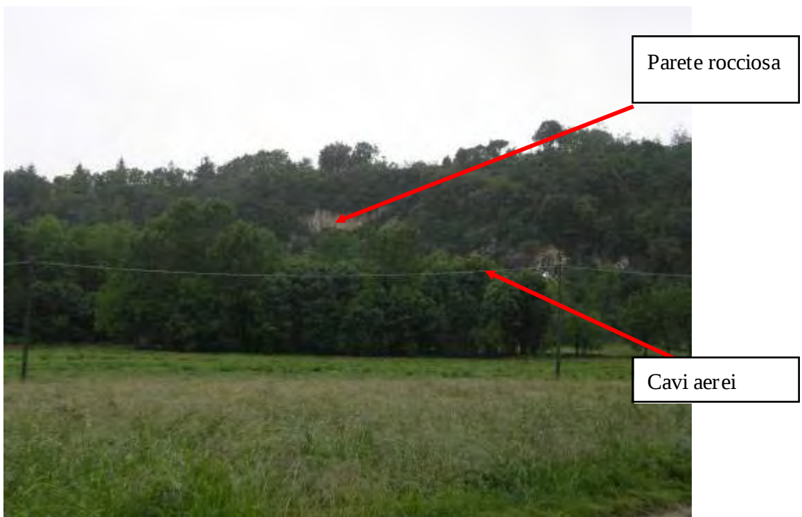
Paretina rocciosa che si affaccia su ambienti aperti. Si può presentare la necessità di mettere in sicurezza i cavi aerei in caso di nidificazione di rapaci rupicoli
