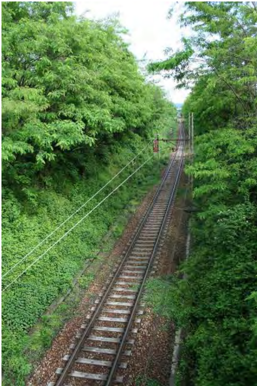
Punto in cui il varco è attraversato da linea ferroviaria
