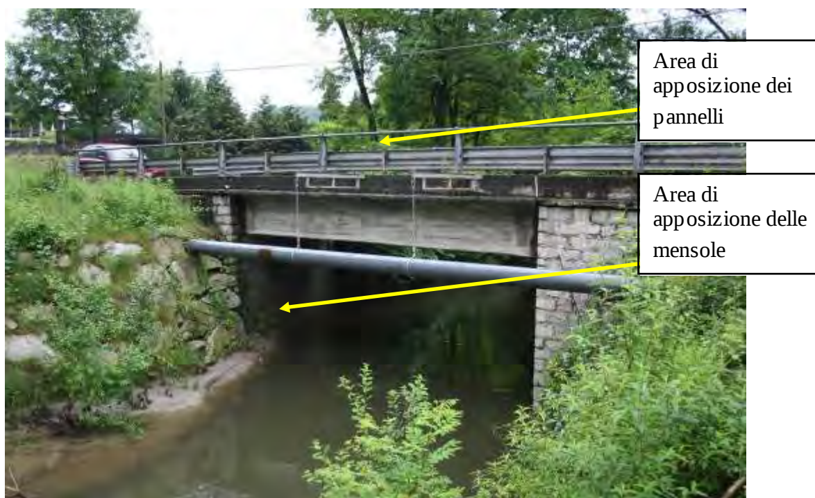
Il punto di passaggio del torrente Acquanegra sotto la S.P. 69
