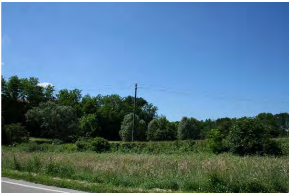
La linea elettrica a valle del ponte sullo Strona, ove si segnala la necessità di messa in sicurezza tramite apposizione di spirali del tipo Bird-Flight Diverters
