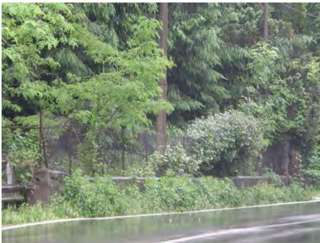
La presenza di un muretto e di recinzioni, lungo la S.P. 50, costituisce impedimento al transito di alcuni mammiferi e di anfibi, al quale si può ovviare tramite apposizione di mensole sui muri portanti ai lati del Fosso della Peschiera
