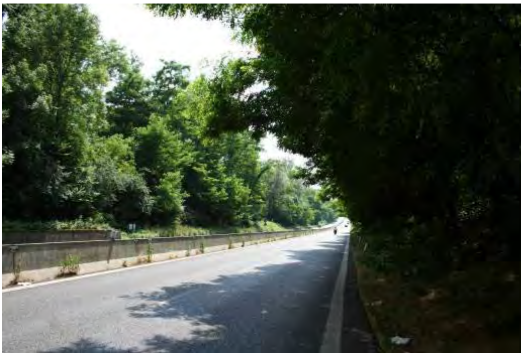
Veduta d'insieme del varco nel punto in cui interseca la S.S. 629 (guardando verso sud)
