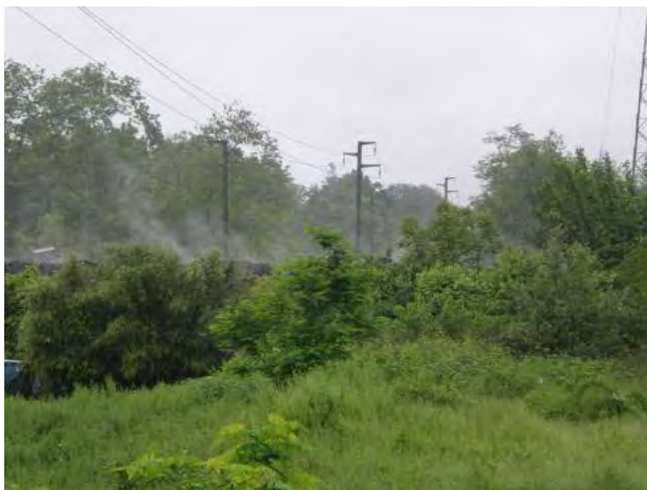
Vista delle linee elettriche nell'area del varco.
