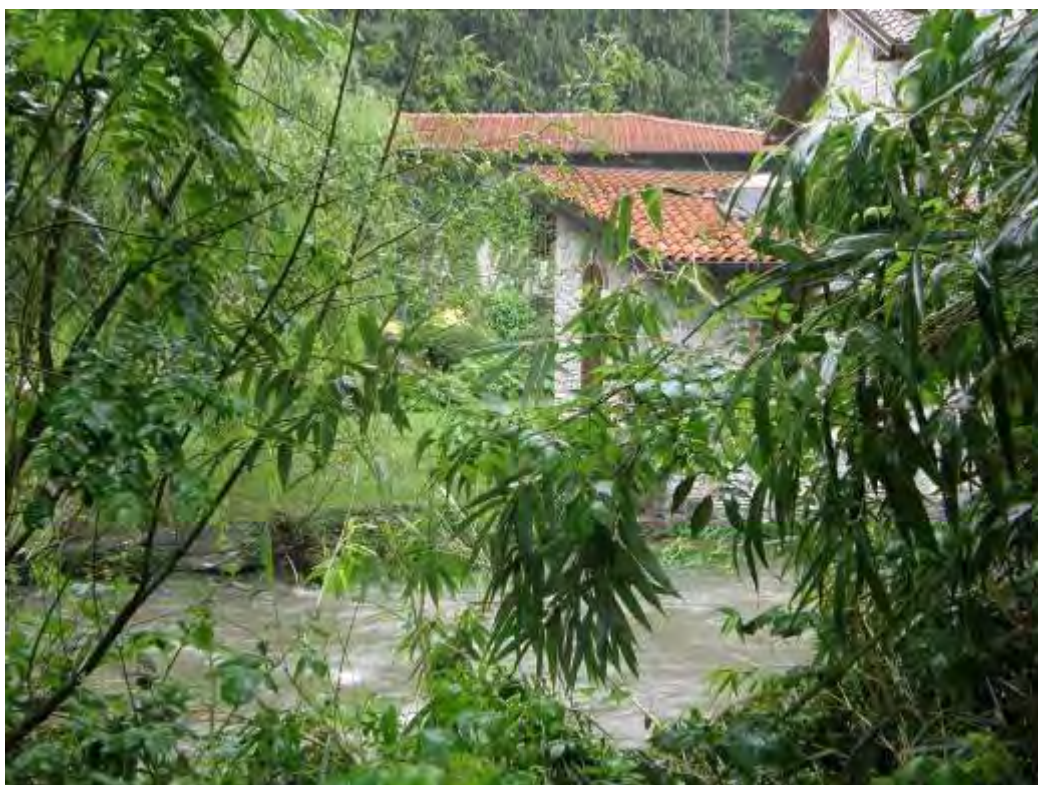
Tratto del fiume Bardello a valle di Bogno.
