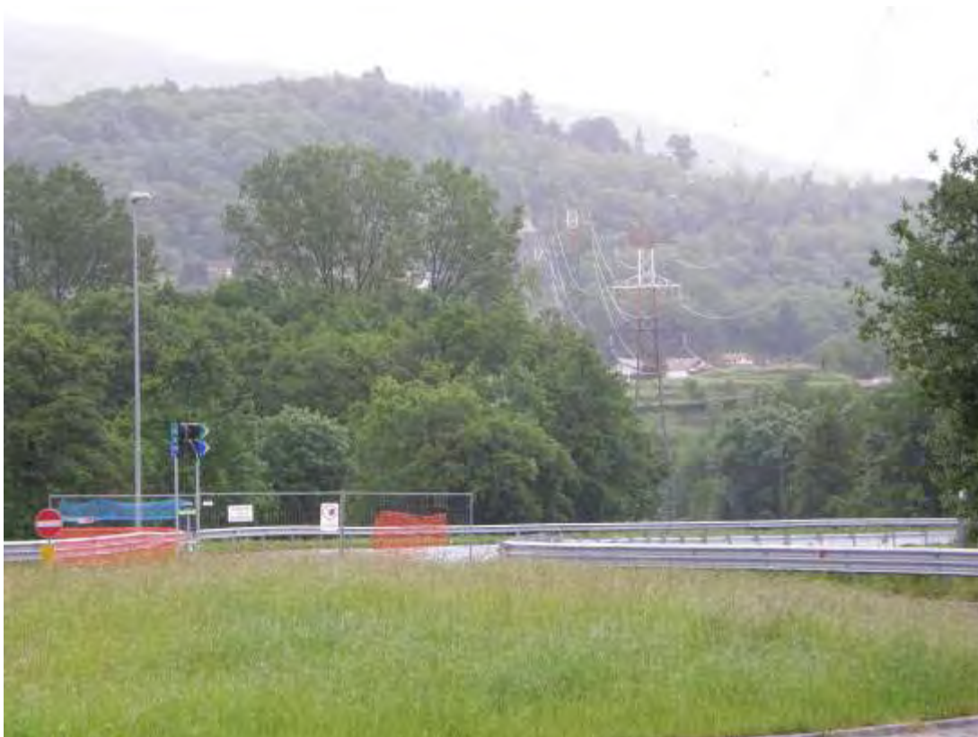
Vista del nuovo tratto della SP1.
