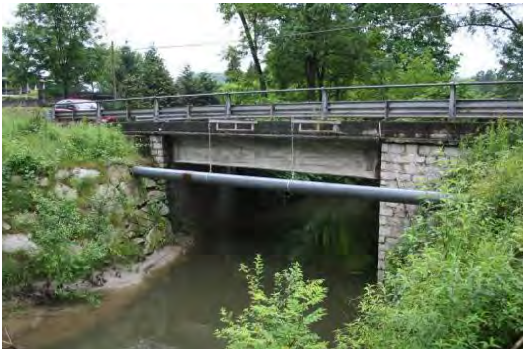
Passaggio del torrente Acquanegra sotto la SP 69 Sesto Calende – Luino.
