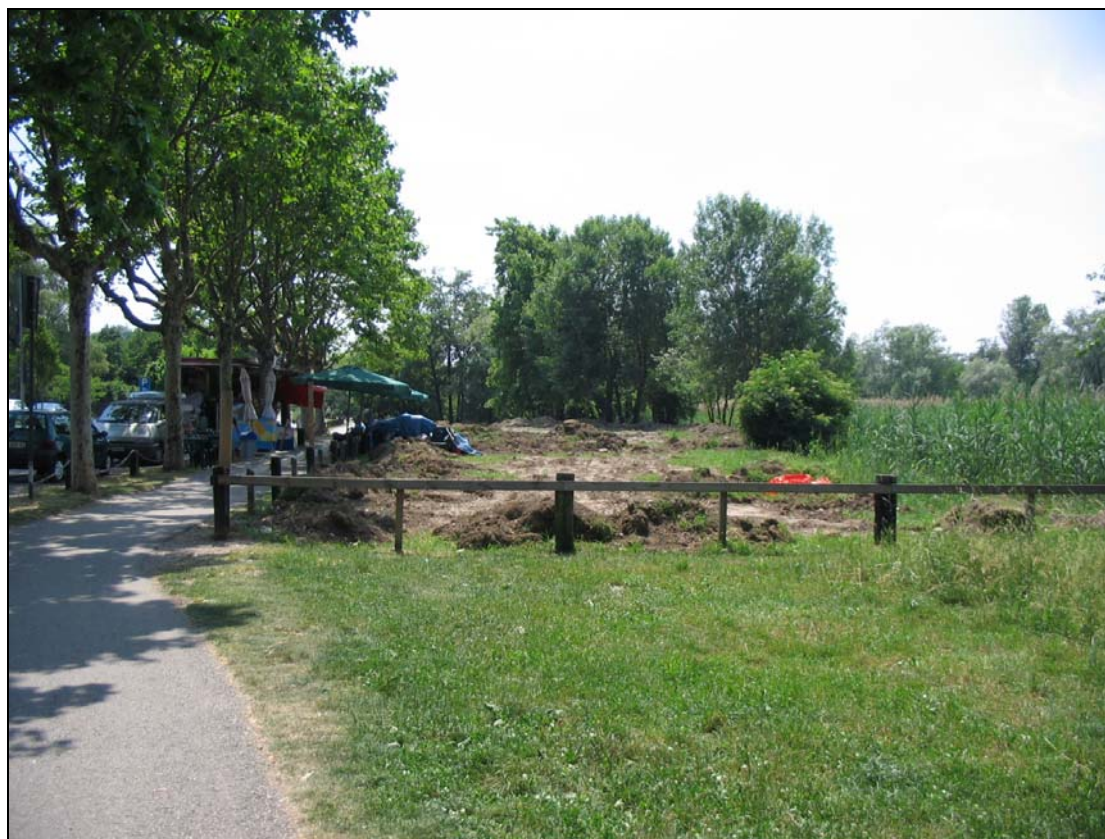
Panoramica area di intervento – vista sud
