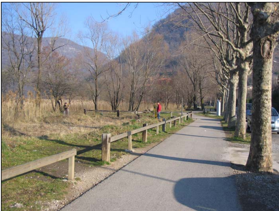
particolare recinzione in legno esistente
