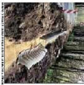
PARTICOLARE COSTRUTTIVO E EL. CORRUCCATO SEZIONATO DA INSTALLARE COME BARRIERA
