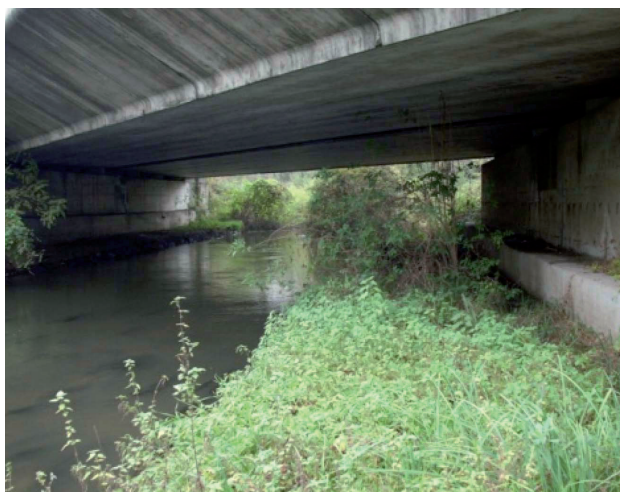
FIG. 6-18 SOTTOPASSO DEL CANALE GRAVELLONE DELLA TANGENZIALE EST DI PAVIA E SCHEMA GRAFICO. LA CONTINUITÀ LONGITUDINALE DELLA RIPA È MANTENUTA
