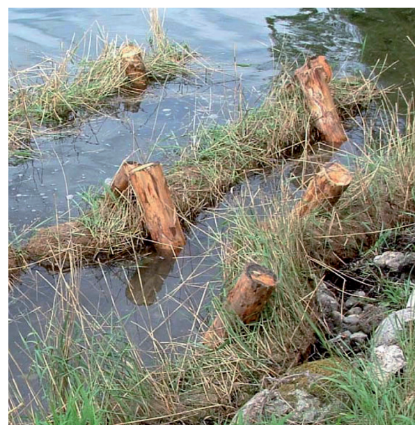
FIG. 6-6 CONSOLIDAMENTO SPONDALE CON RULLI DI ELOFITE.
