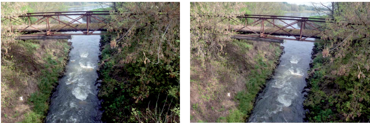
FIG. 8-4: POSA DI MASSI SOMMERSI PRIMA DELL'IMMISSIONE NEL FIUME TICINO: ANTE OPERAM (SOPRA) E POST OPERAM (SOTTO).
