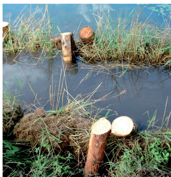
FIG. 6-5 POSA DI RULLI SPONDALE DI CANNETO CON PALI IN CASTAGNO.
