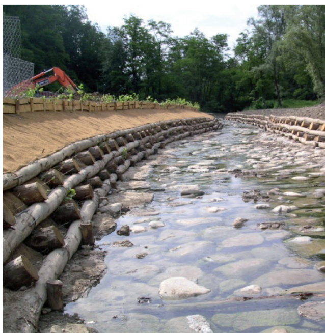
FIG. 6-11 INTERVENTO REALIZZATIVO DI PALIFICATA SU ENTRAMBE LE SPONDE.
