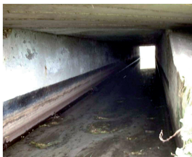
FIG. 6-17 SOTTOPASSO DELL'AUTOSTRADA A7 MILANO/GENOVA.
