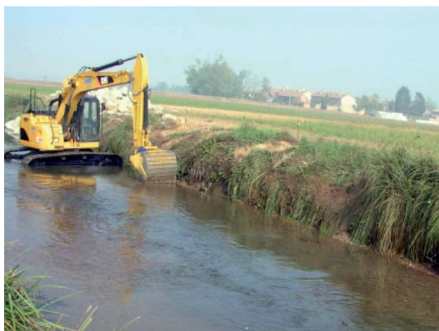
FIG. 6-22 SCAVO SI UNA BUCA IN UN CANALE IRRIGUO
