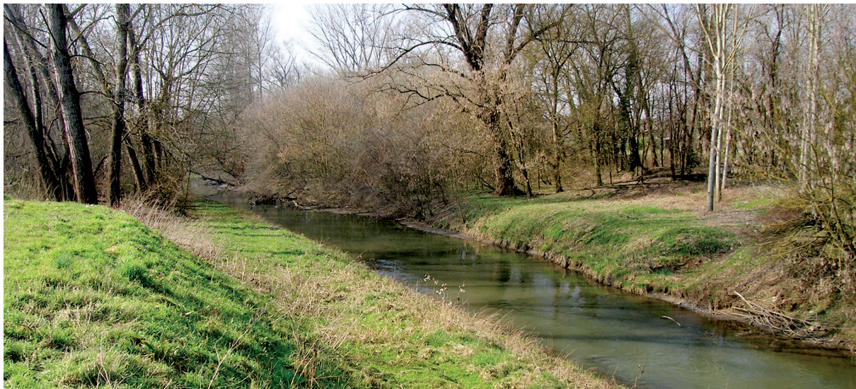
FIG. 4-9 COLATORE GRAVELLONE PRIMA DEGLI INTERVENTI DI DEFRAMMENTAZIONE
