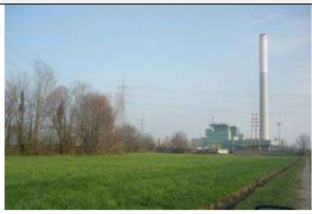
Interruzione della continuità dell'alzaia all'altezza della Centrale Termoelettrica
