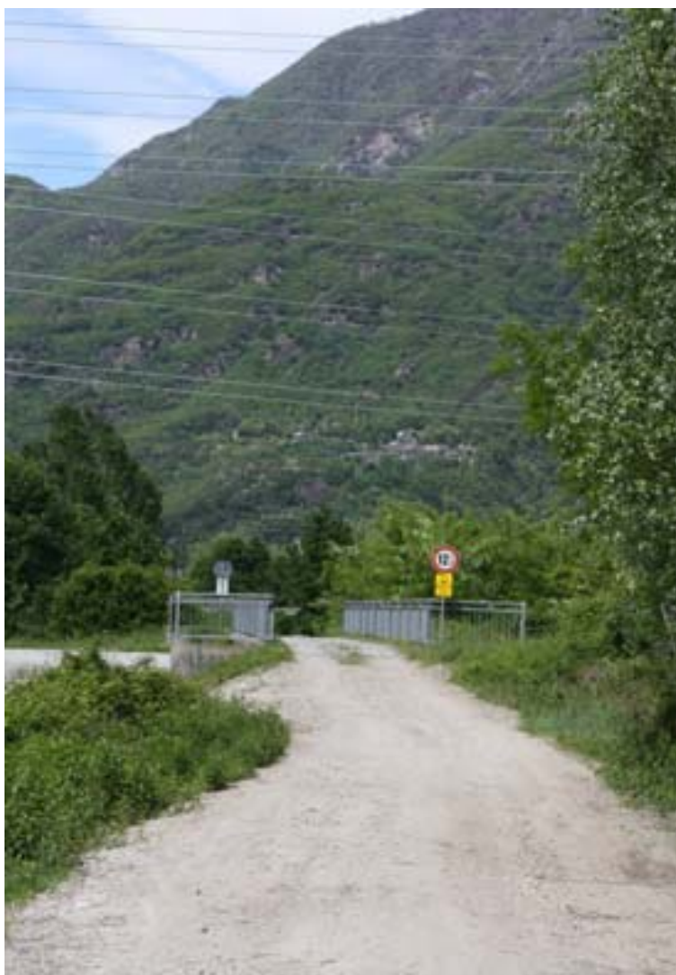
Una delle passerelle sul canale Edison
