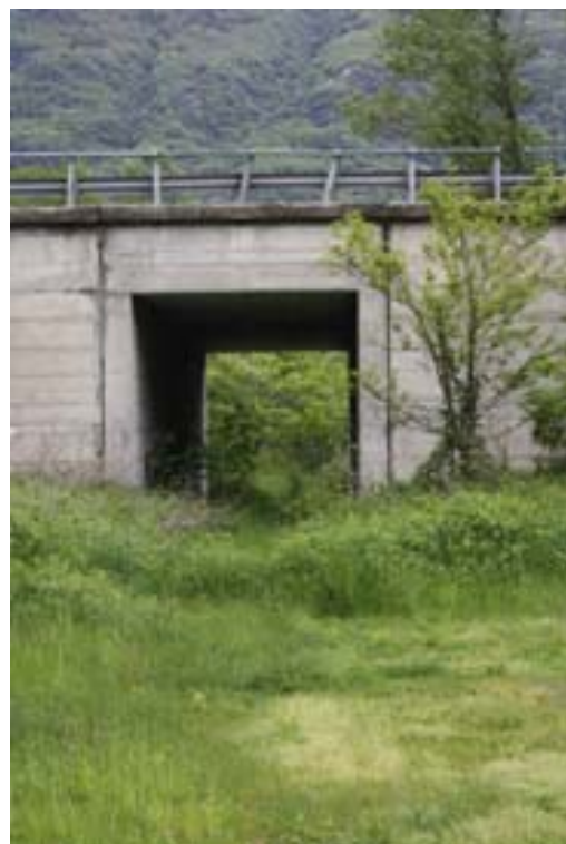
Sottopassaggio della E62
