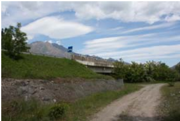
Cavalcavia E62 in corrispondenza del varco
