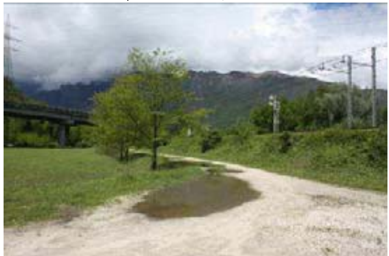
Linea ferroviaria, vista est
