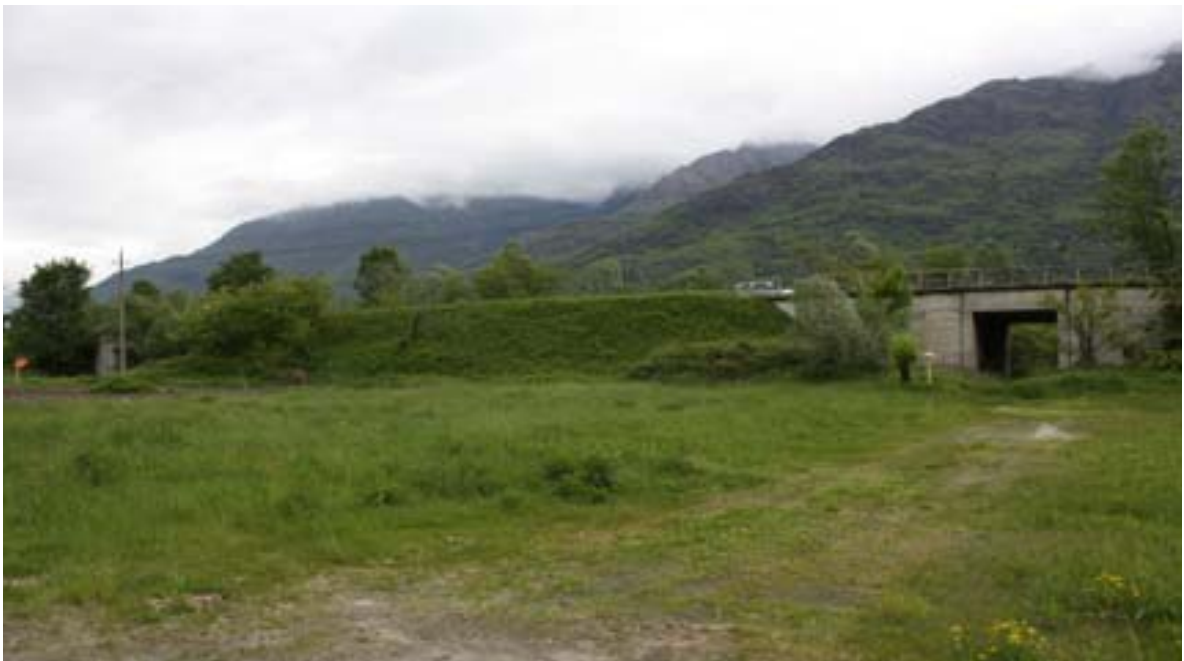
Sottopasso pedonale della E62
