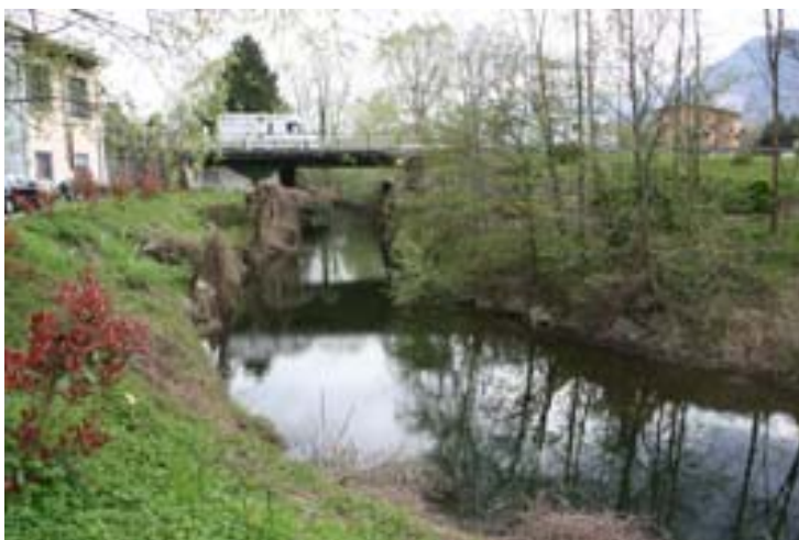
Vista del ponte sul canale
