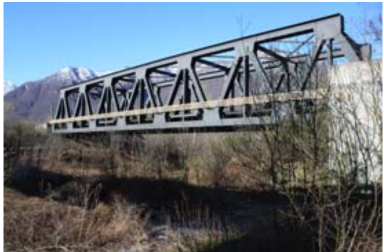
Sottopasso linea ferroviaria scalo Domo 2
