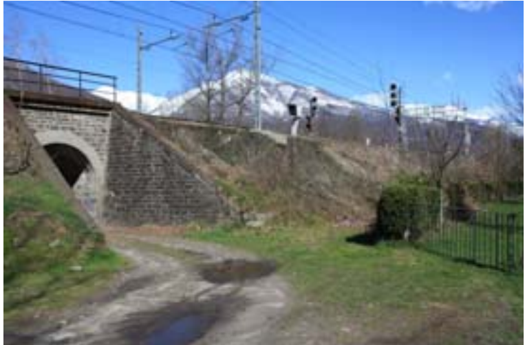
Sottopasso e linea ferroviaria
