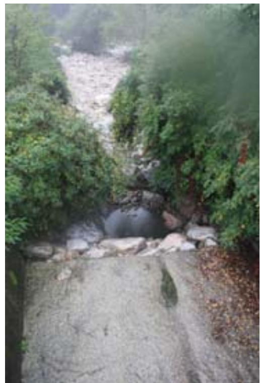
Particolare sottopasso SR229
