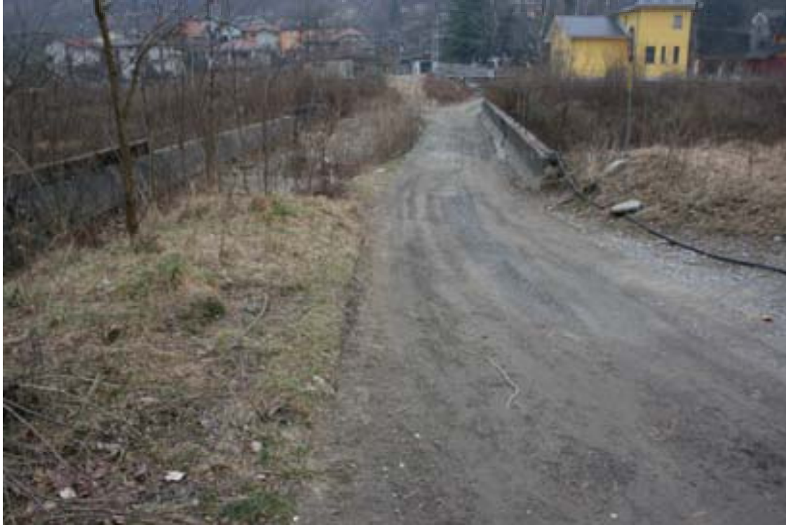
Veduta della passerella sul canale Edison
