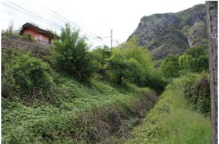
Cavalcavia E62 sul fiume Toce
