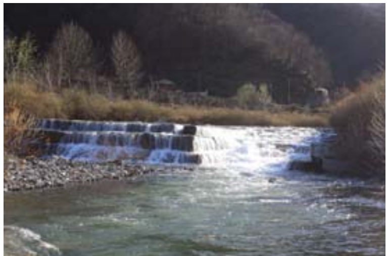
Particolare della soglia
