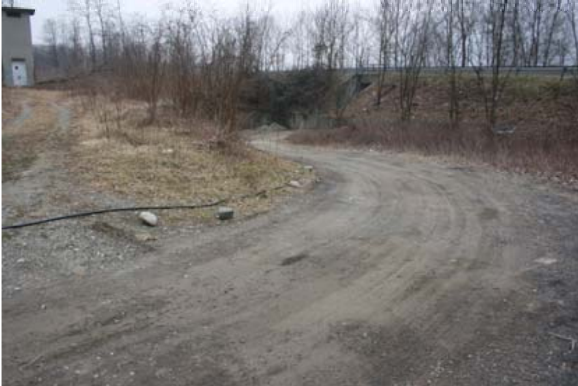
Tratto tra la passerella sul canale Edison e l'ingresso del sottopasso della E62
