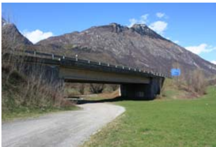
Sottopasso E62, vista est
