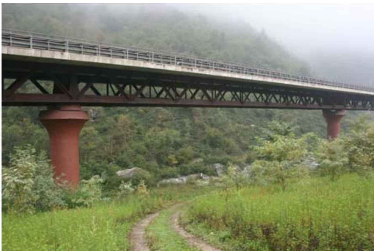
Cavalcavia della S.S. 33 in corrispondenza del varco
