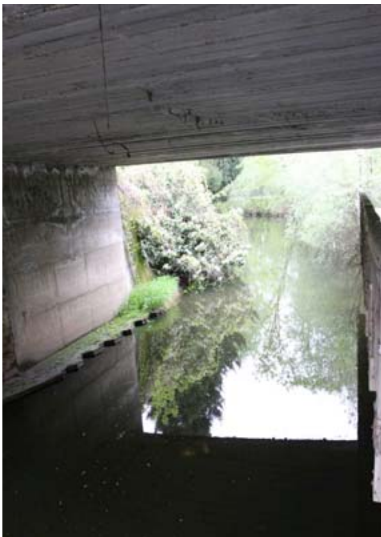
Veduta del sottopasso lungo la S.S. 34. A destra si intravede la staccionata della passerella della pista ciclabile. La mensola osservabile sul lato opposto in realtà si restringe fino ad appena pochi centimetri
