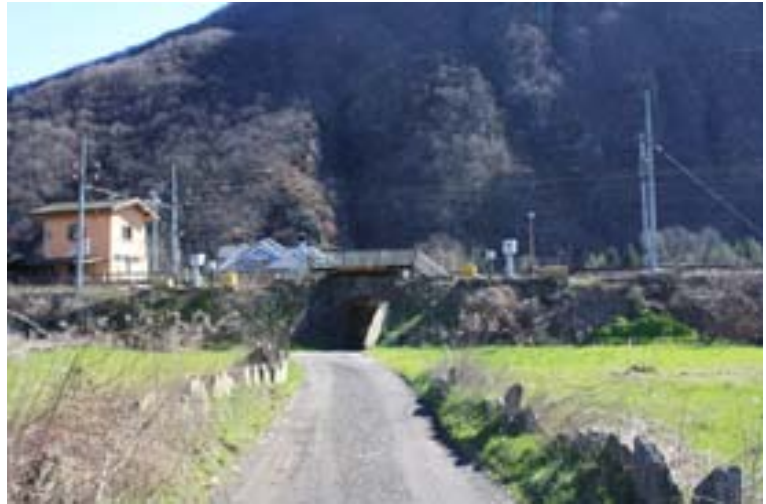
Sottopasso e linea ferroviaria
