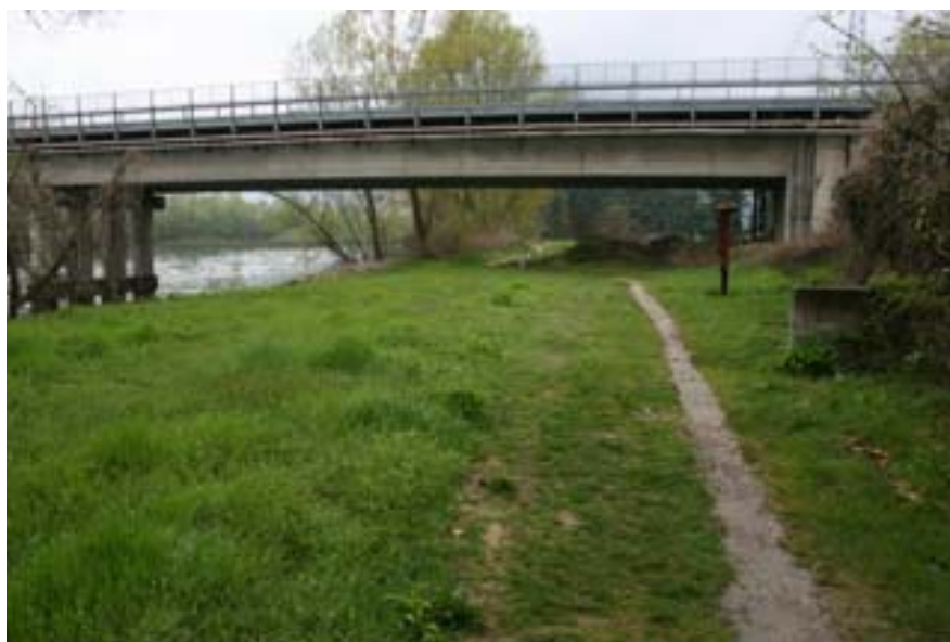
Cavalcavia della S.P. 126 in prossimità del fiume Toce
