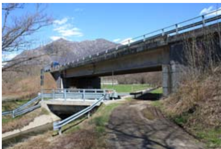
Vista sottopasso E62, lato ZPS
