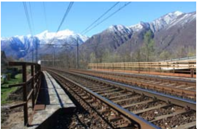
Particolare della linea ferroviaria Domodossola - Milano
