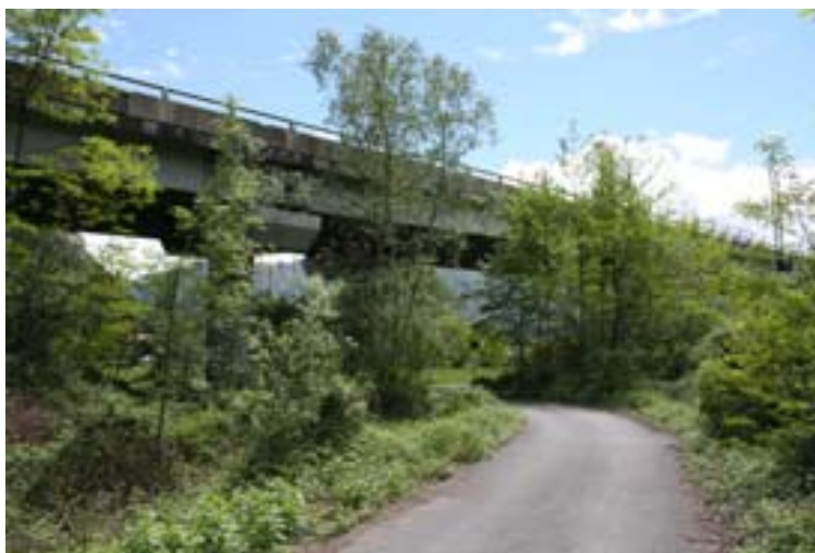
Cavalcavia della E62 nei pressi del varco
