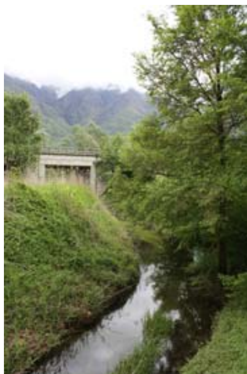
Corso d’acqua e sottopasso E62
