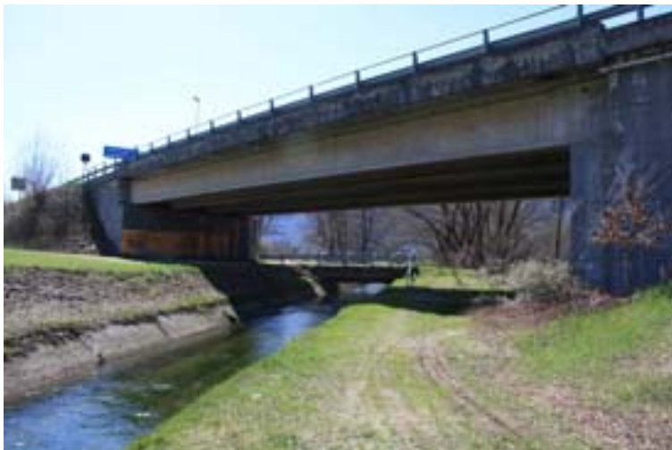
Vista sottopasso E62 e canale
