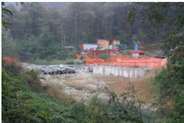
Rio Stronetta con opere di cantiere
