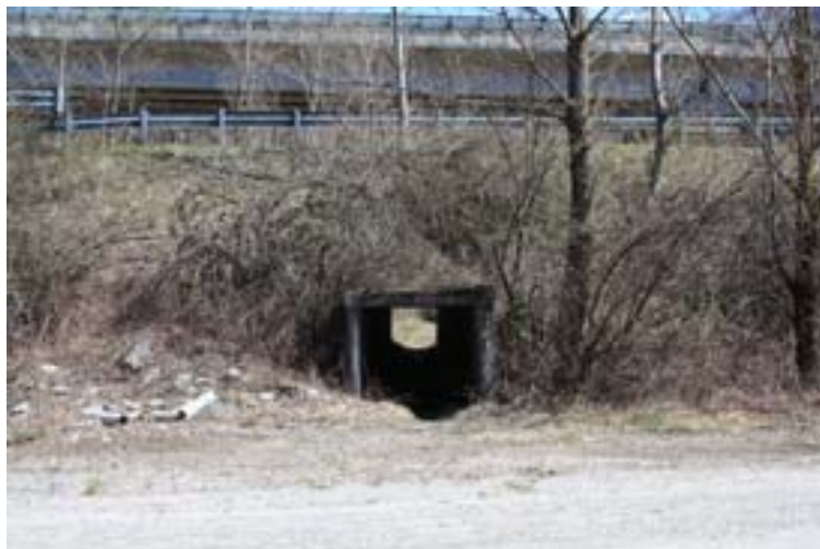
Particolare sottopassaggio S.S. 659
