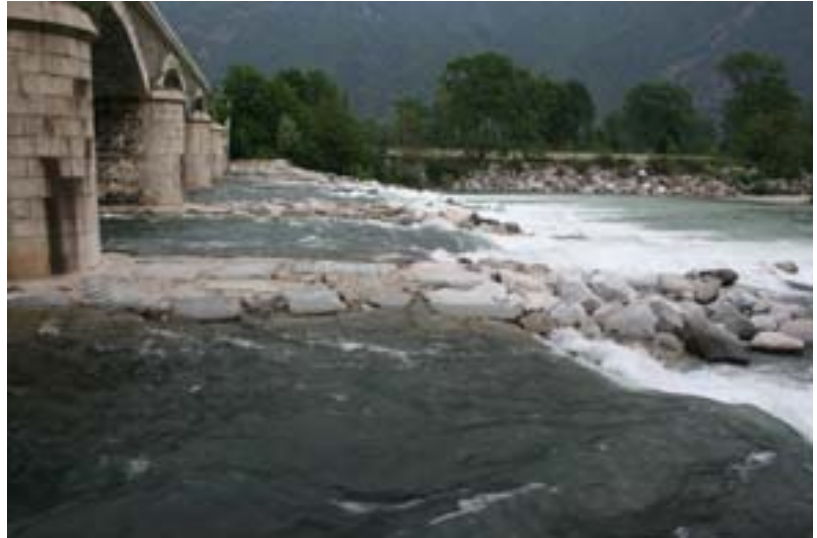
Ponte sul fiume Toce tra Migliandone e Cuzzago
