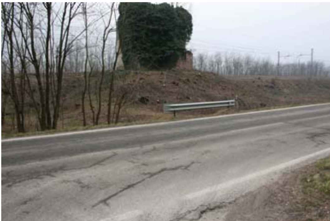
· La scarpata ferroviaria in prossimità del varco
