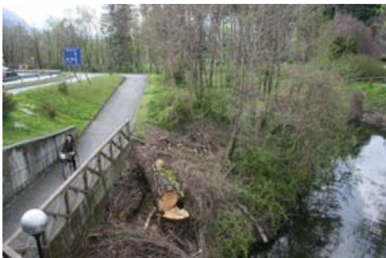
Tratto del canale e della pista ciclabile a nord del varco
