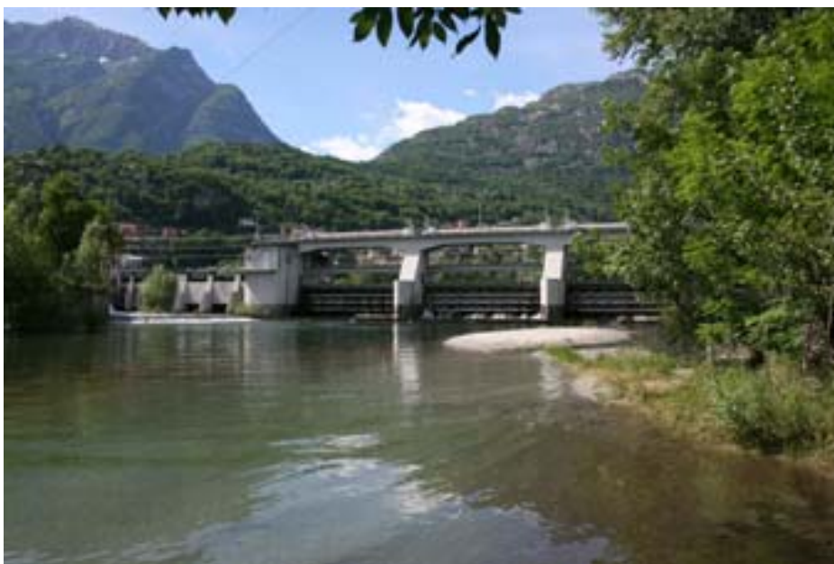
Vista della traversa sul fiume Toce
