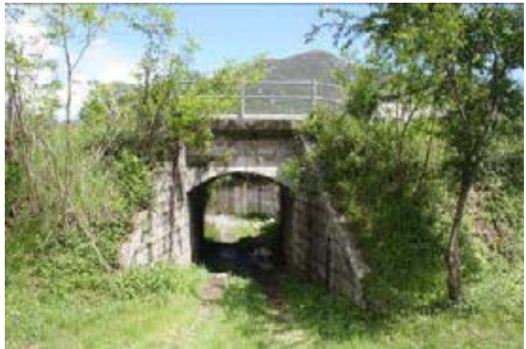
Sottopasso ferroviario, vista ovest
