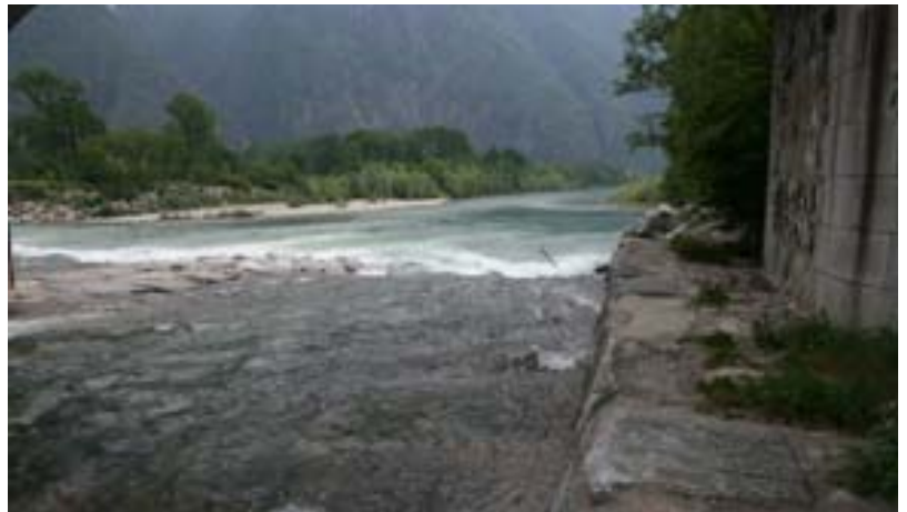
Mensola in massi e cemento alla base del ponte, presente solo in destra orografica
