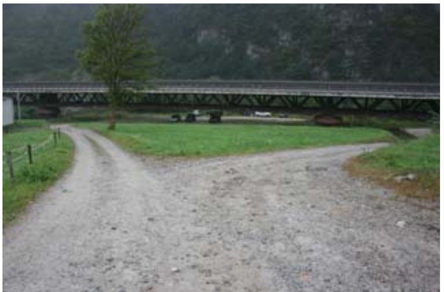
Tratto di cavalcavia della SS33 in corrispondenza del varco
