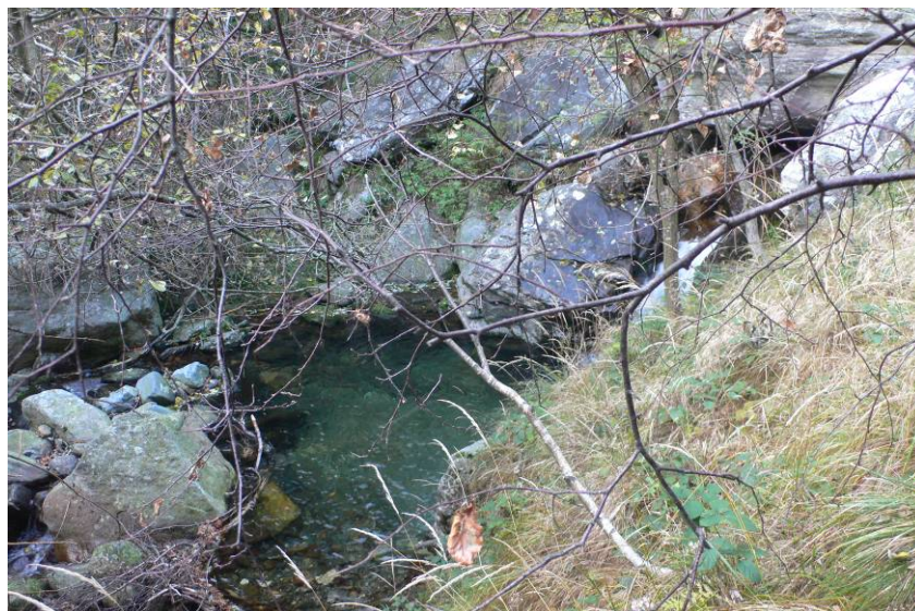
Alpe Pian di Boit: punto presa acqua
