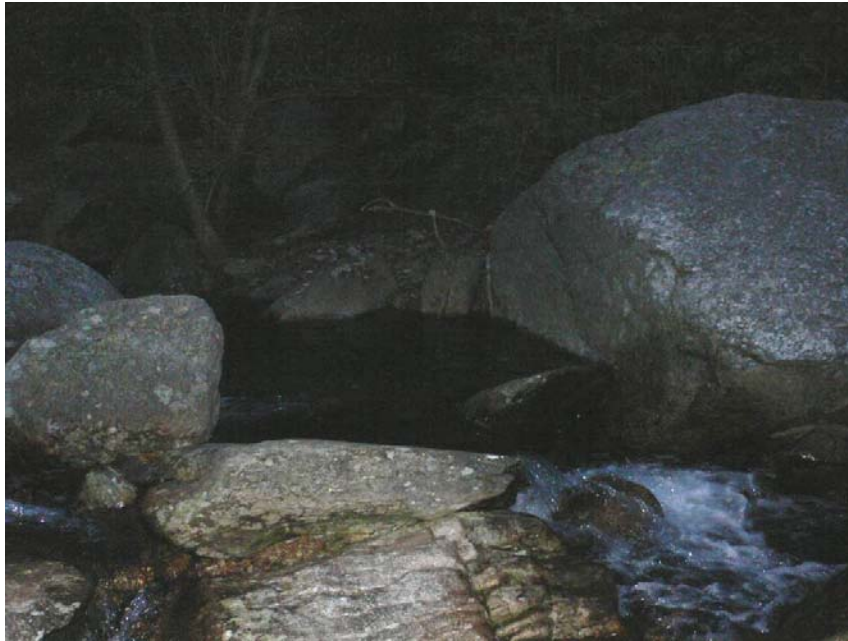
Alpe Guara: presa acqua lungo il torrente
