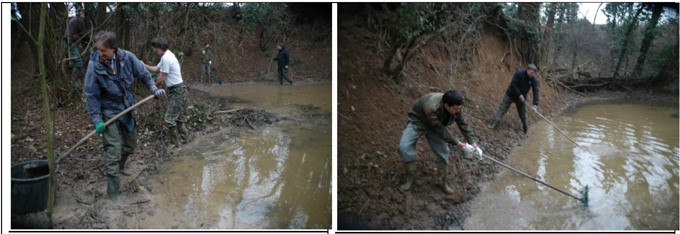
Fig.1 –Scavo a mano del detrito.
