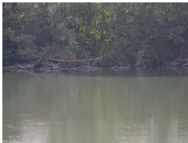
Elementi di diversificazione già presenti in alveo (sponda sinistra, salendo verso il ponte).
