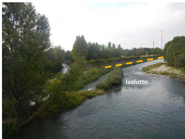
Isolotto a valle del ponte ed inizio del tratto di scogliera (in arancione).
