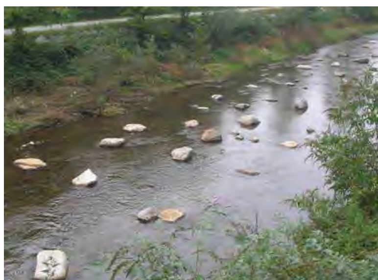
A sinistra: consolidamento spondale; massi in alveo (web)
