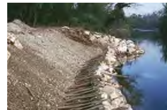
Particolari intervento di consolidamento spondale (web)
