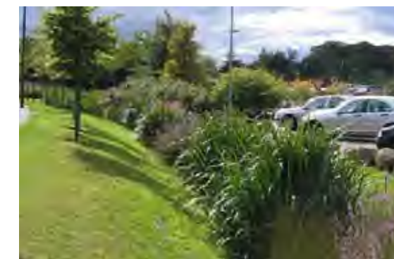
Stagno seminaturale realizzato in un Parco pubblico e stagno lineare di recupero delle acque di piattaforma
