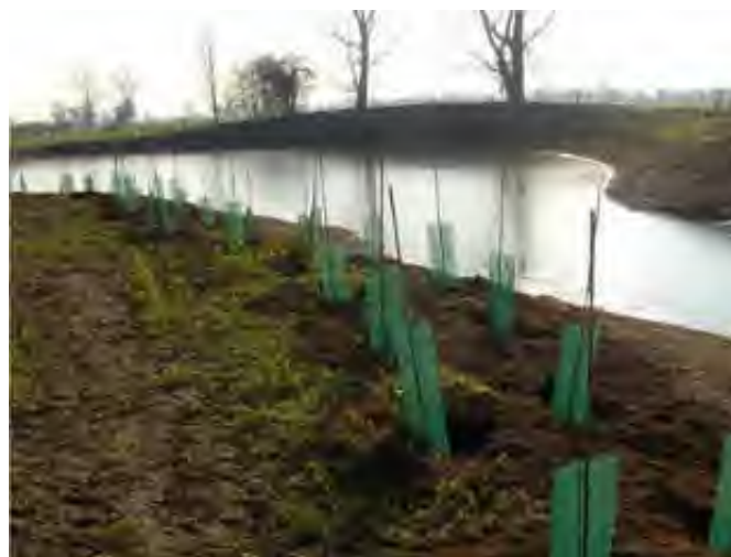
Particolare intervento di ingegneria naturalistica con utilizzo di talee e piantumazione ripariale (web)
