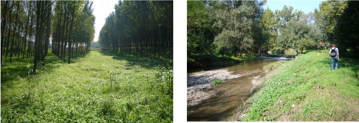
Figura 2 – Area di intervento e scarico nel fiume Olona
