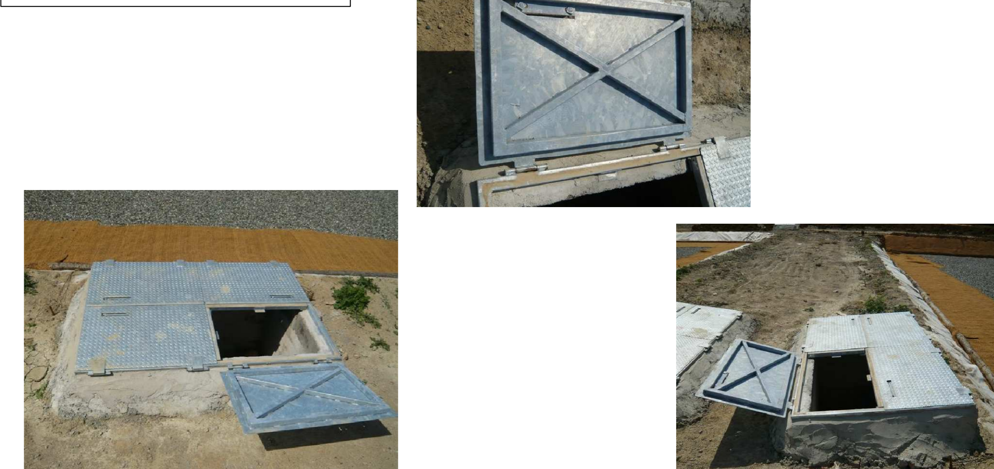
CHIUSINO IN FERRO ZINCATO A CALDO E MARTELLINATO
