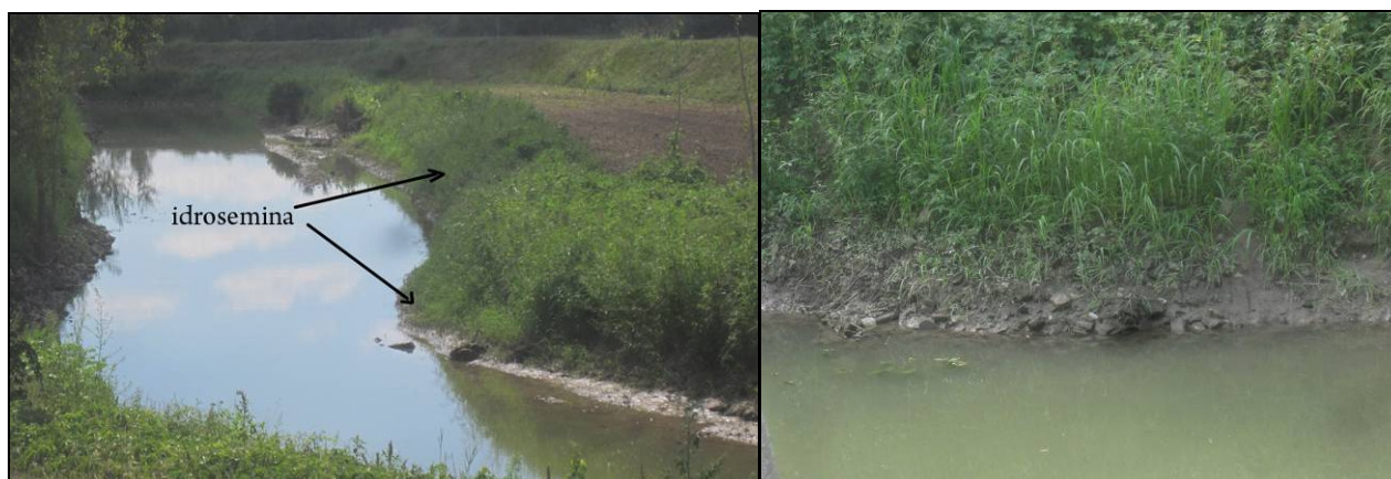
Figura 2 – I primi effetti dell’idrosemmina alla base della sponda; in particolare nella foto di destra, si può osservare lo sviluppo di Carex acutiformis ad un mese dalla realizzazione delle operazioni.
